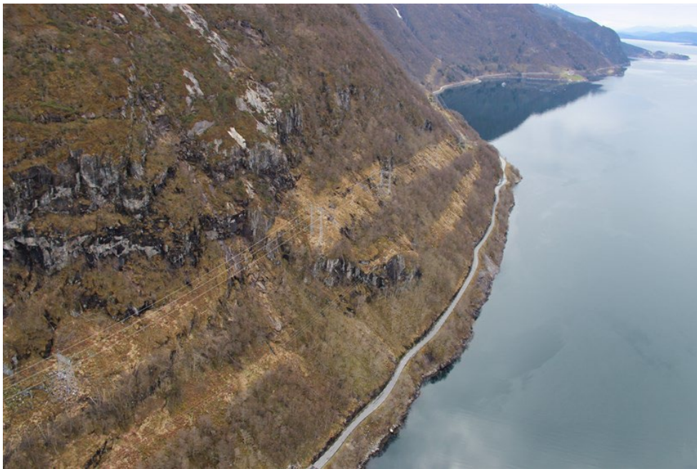
Figur 10: Bildet viser dagens ledning langs Maurangerfjorden, i retning Rosendal. Kilde: Statnett
