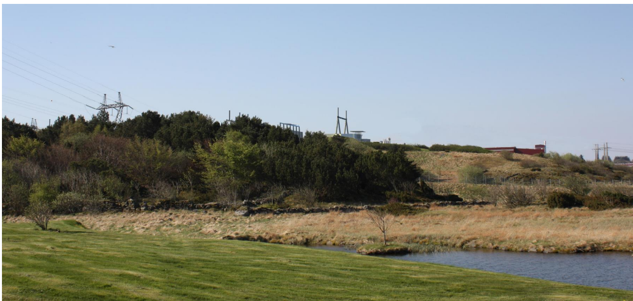
Figur 6. Visualisering av omsøkte tiltak sett fra Høyeverde nordøst for stasjonen. Illustrasjonen er utarbeidet av Sweco.
