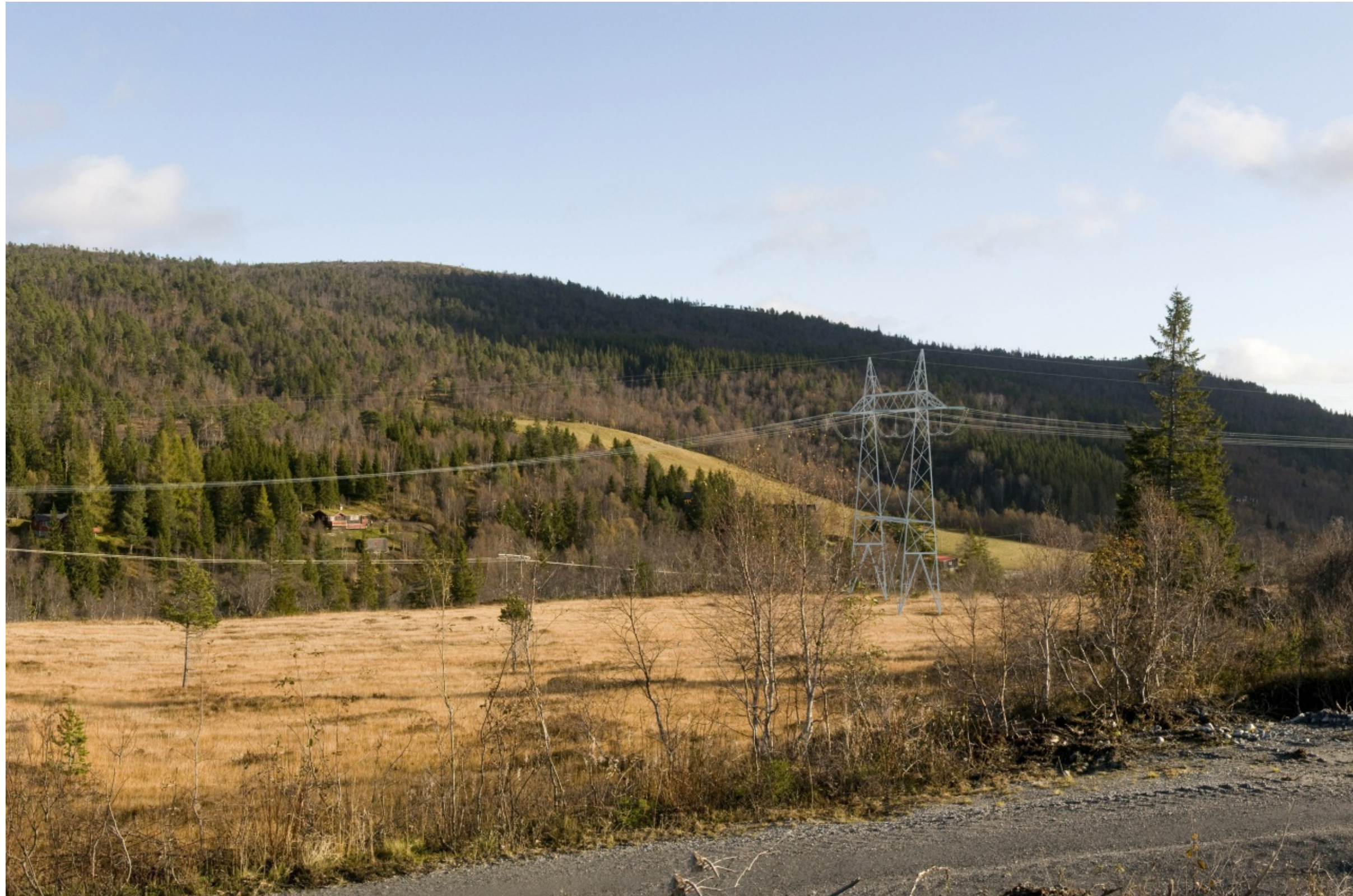
Visualisering fra Hardmoen med triplex linetverrsnitt (Storheia-Orkdal/Trollheim). Linene okkuperer et noe bredere felt i bildet enn duplex. Fotoillustrasjon: Norconsult.
