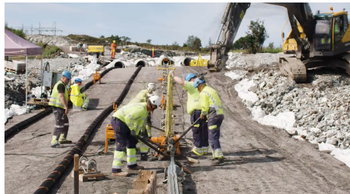
Modalen-Lindås: Verdens lengste og dypeste 420 kV PEX kabel i Fensfjorden bidrar til bla. økt forsyningssikkerhet i Bergensregionen.
