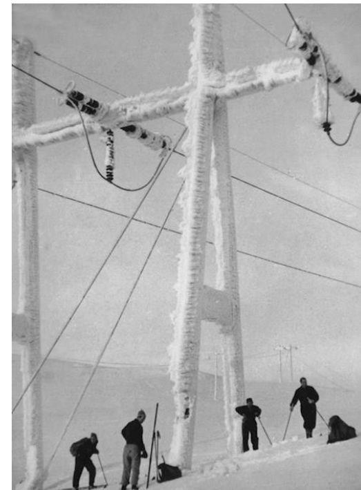
Vinstra Kraftselskap inspiserer Nedre Vinstra–Oslo vinteren 1960. Foto: Statnett
