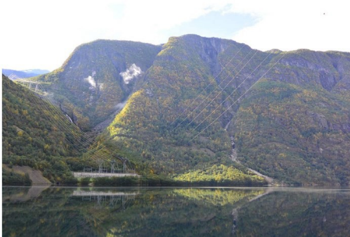
Figur 2: Aurland 1 koblingsstasjon sett fra Vassbygdevatn mot sør. Utvidelsen planlegges mot høyre. Grimsetelvi sees ovenfor stasjonen og Kråkagjelet ovenfor rasviften til høyre
