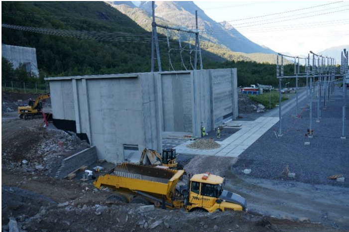
Figur 3: Eksempel på transformatorsjakter i betong
