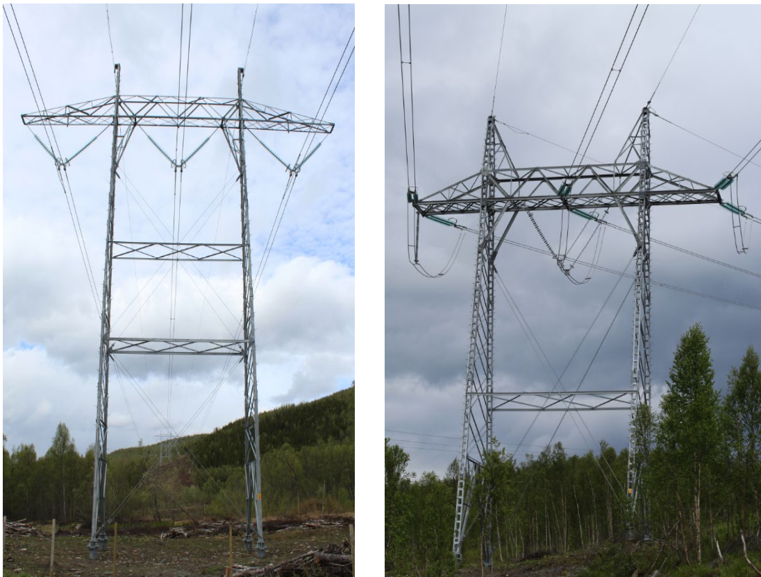
Figur 4: Illustrasjonsbilder av Statnetts 420 kV portalmast. Bæremast til venstre, forankringsmast til høyre.
