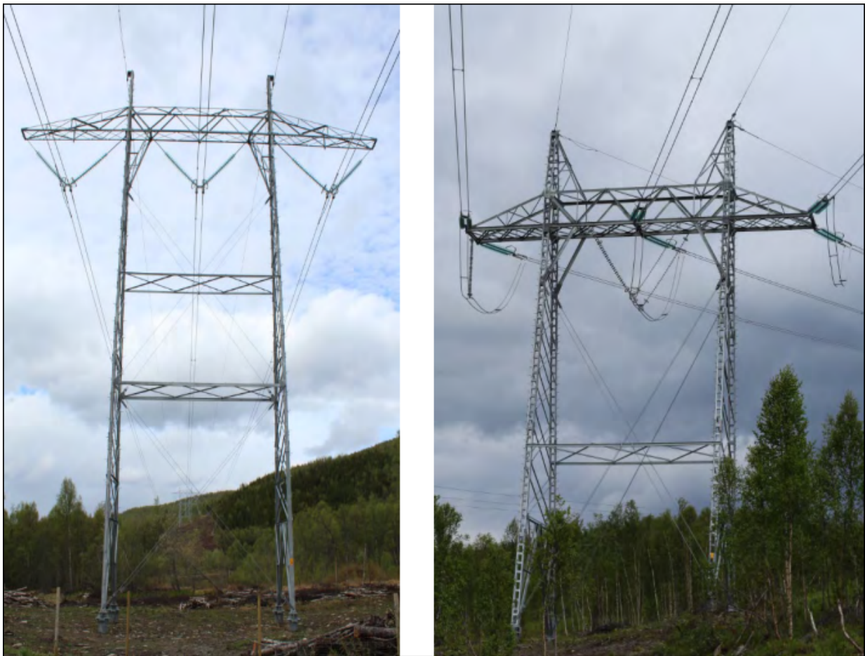
Figur 4: Illustrasjonsbilde av Statnetts 420 kV portalmaster. Venstre: bæremast. Høyre: forankringsmast. Kilde: Statnett.
