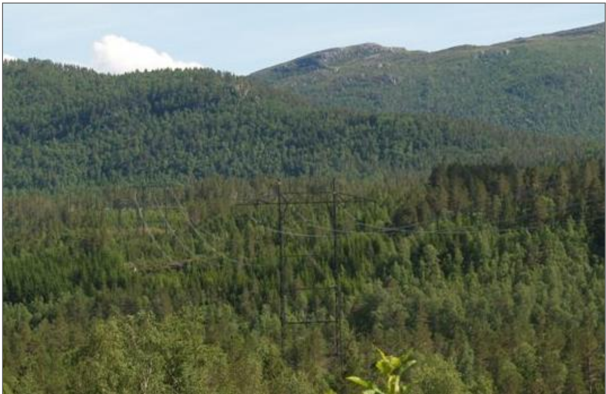
Figur 11. Bilde av kamuflert kraftledning. Mastene er grønnmalt, linene er mattede, og isolatorene er av kompositt i stedet for av glass som er vanligst å benytte
