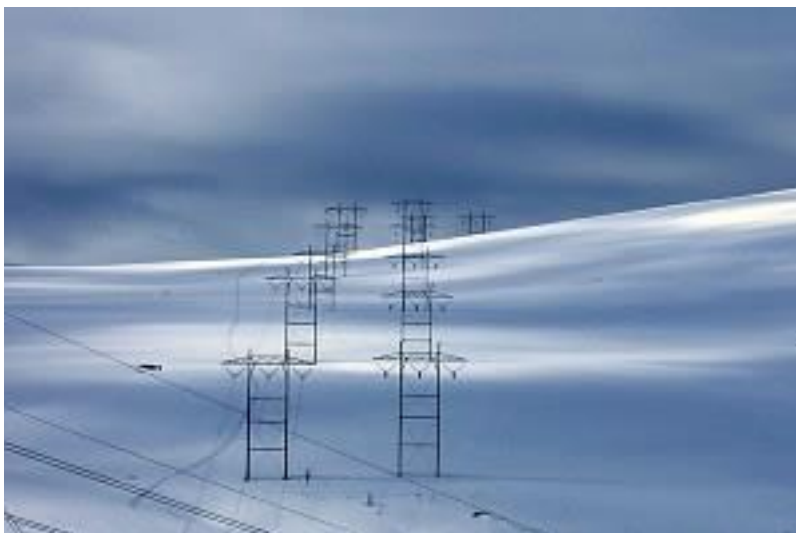
Figur 12. Det oppfattes som mest ryddig å ha samme mastetype når ledninger går parallelt i terrenget. Bildet viser eksempel fra 132 kV ledningene mellom Kvandal – Kanstadbotn og Kvandal – Kvitnes. Foto: Statnett
