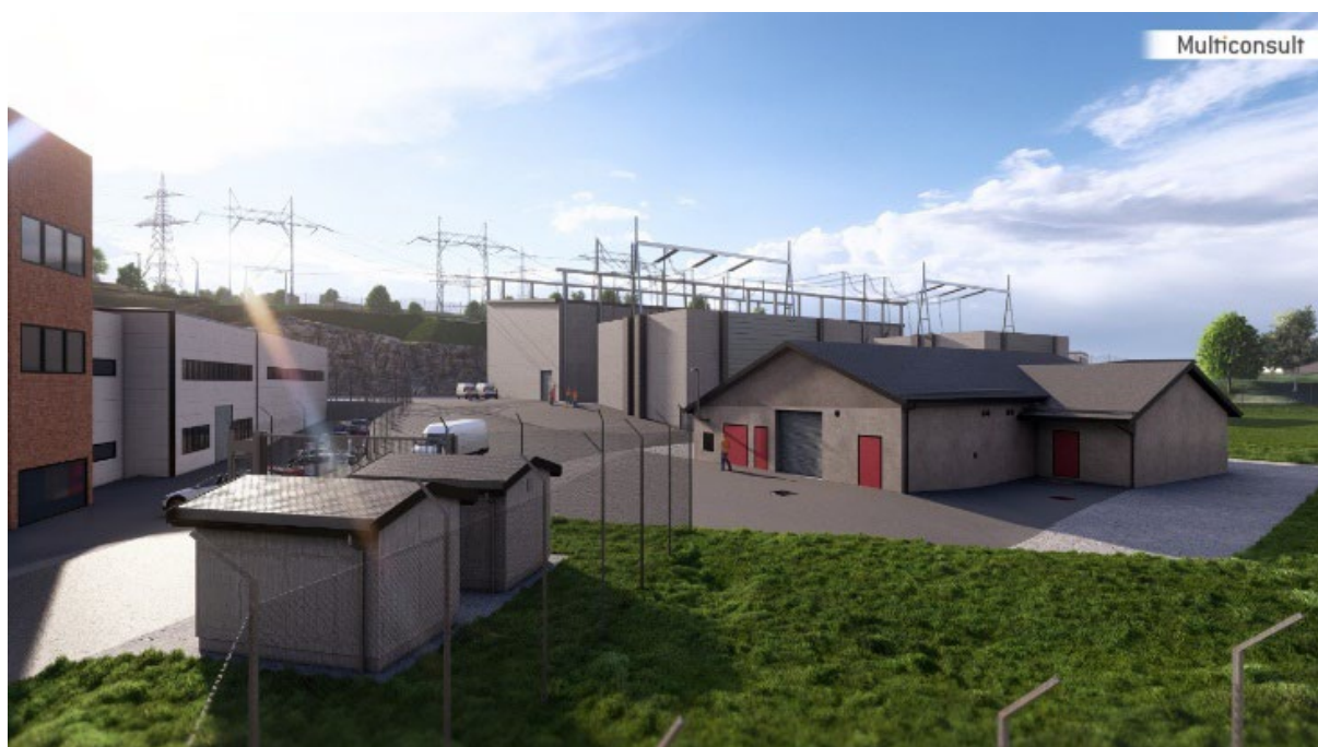
Figur 8: Visualisering av GIS-bygg (lengst bak) og transformatorsjakter, kontrollhus (med røde dører) samt to mindre tekniske bygg (i forgrunnen).
