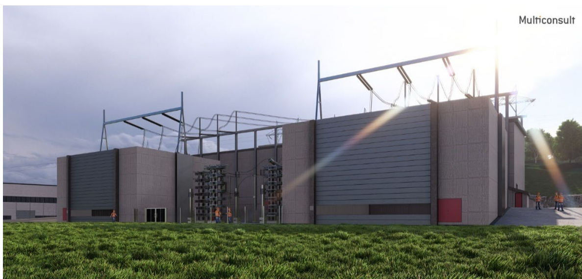
Figur 7: GIS-bygg, kondensatorbatteri og transformatorsjakter i Humleberget transformatorstasjon.
