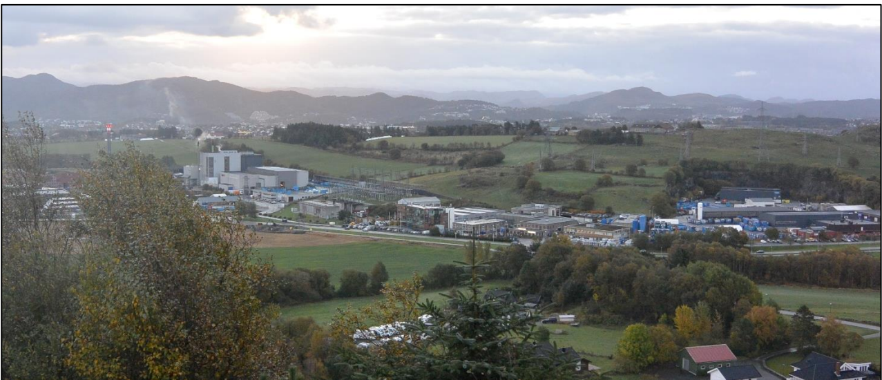
Figur 1-3. Oversiktsbilde over tiltaksområdet på Humleberget sett fra Kjerrberget i nordvest. Ny transformatorstasjon vil ligge i eksisterende industriområde ca. midt i bildet. Eksisterende Bærheim transformatorstasjon ligger rett ved til venstre i bildet. Foto: Multiconsult.
