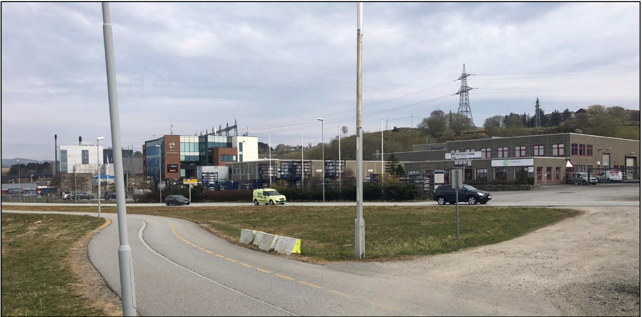
Figur 1-4. Nærbilde av tiltaksområdet på Humleberget sett fra Forusbeene. Deler av eksisterende Bærheim transformatorstasjon kan sees i venstre bildekant. Foto: Multiconsult.
