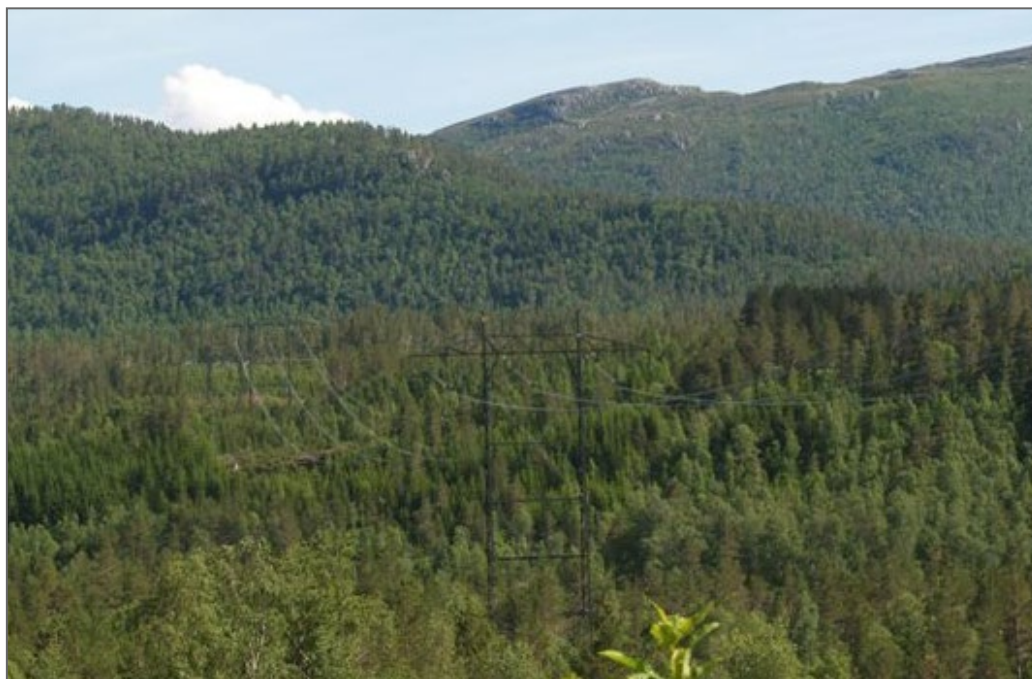
Figur 19. Foto av kamuflert kraftledning. Linene er mattede, og isolatorene er av kompositt i stedet for av glass som er vanligst å benytte. Foto: Statnett.
