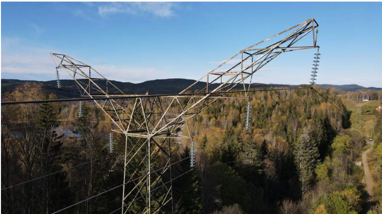
Figur 4-24 Mast nr. 322, den siste englemasta langs strekningen, i forgrunnen. Underkant av travers ligger 16,3 meter over bakken. Total mastehøyde er 21,6 meter. Bogstadvannet og Bogstad gård til venstre i bildet (vest for ledningen).
