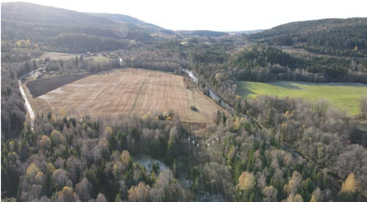
Figur 4-20 Ledningen går langs Sørkedalselva mot sør. Mast nr. 307 (total mastehøyde 23,1 meter) nærmest i bildet.
