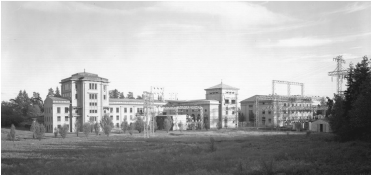
Figur 4-51 Smestad transformatorstasjon fotografert fra nord i 1936. Den eldste delen ligger midt i bildet. I 1928 ble dette anlegget bygget på mot nordøst, og et nytt fasekompensatorhus ble bygget i sørvest (til høyre i bildet). Kilde: Oslo byarkiv
