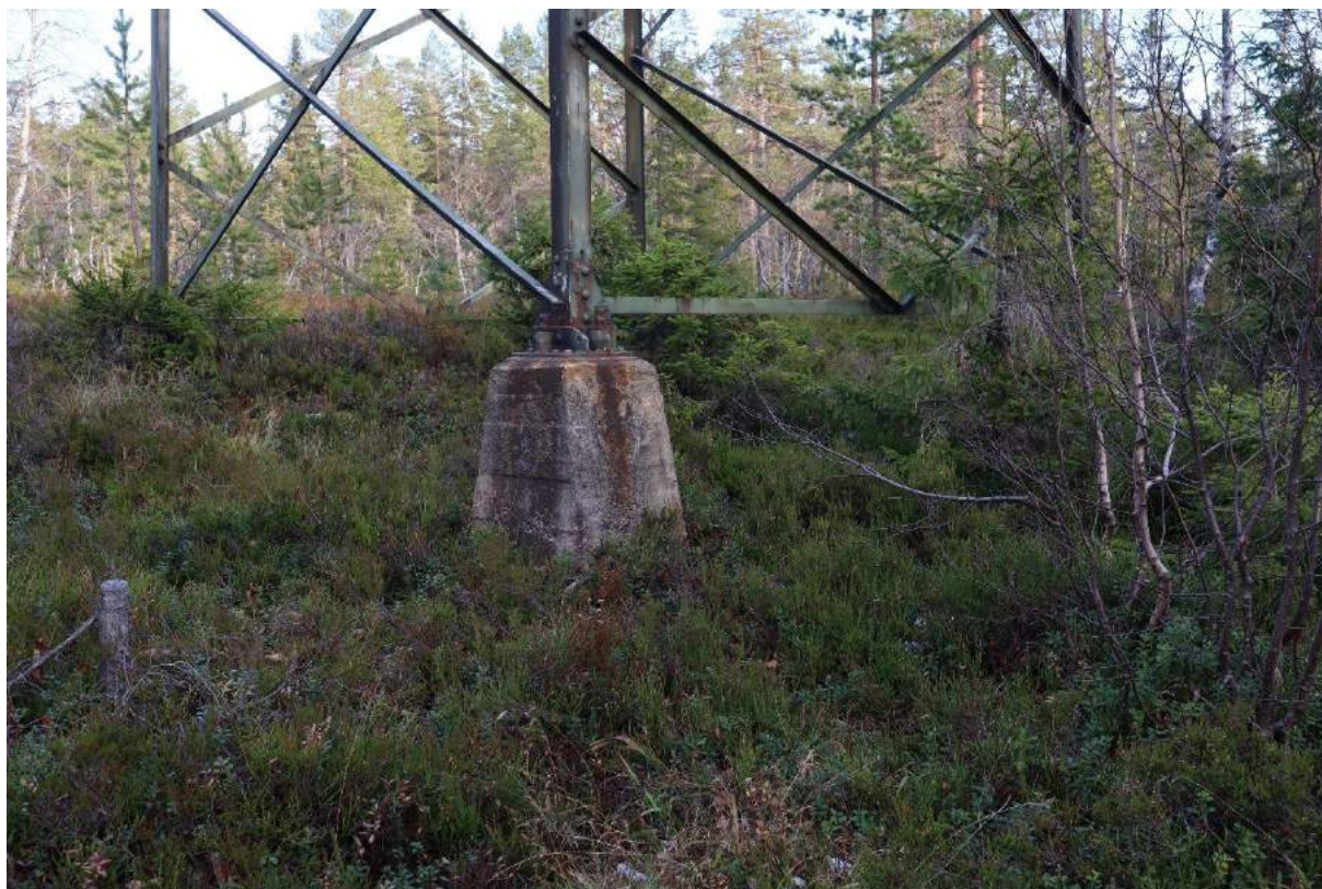
Figur 4-40 Betongfundament til mast nr. 265.
