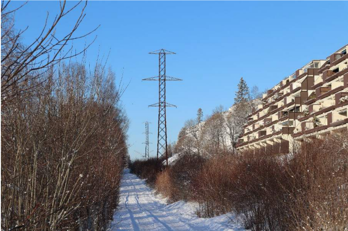
Figur 4-38 Smalere tårnmaster ved Voksenlia. Nærmeste mast (nr. 324) har en total mastehøyde på 36,6 meter. Ledningens siste englemast (nr. 322) sees i bakgrunnen, foto mot nord. Liner og armatur var i januar 2022 nedmontert.
