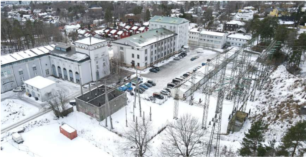
Figur 4-52 Smestad transformatorstasjon sett fra nord i 2022.
