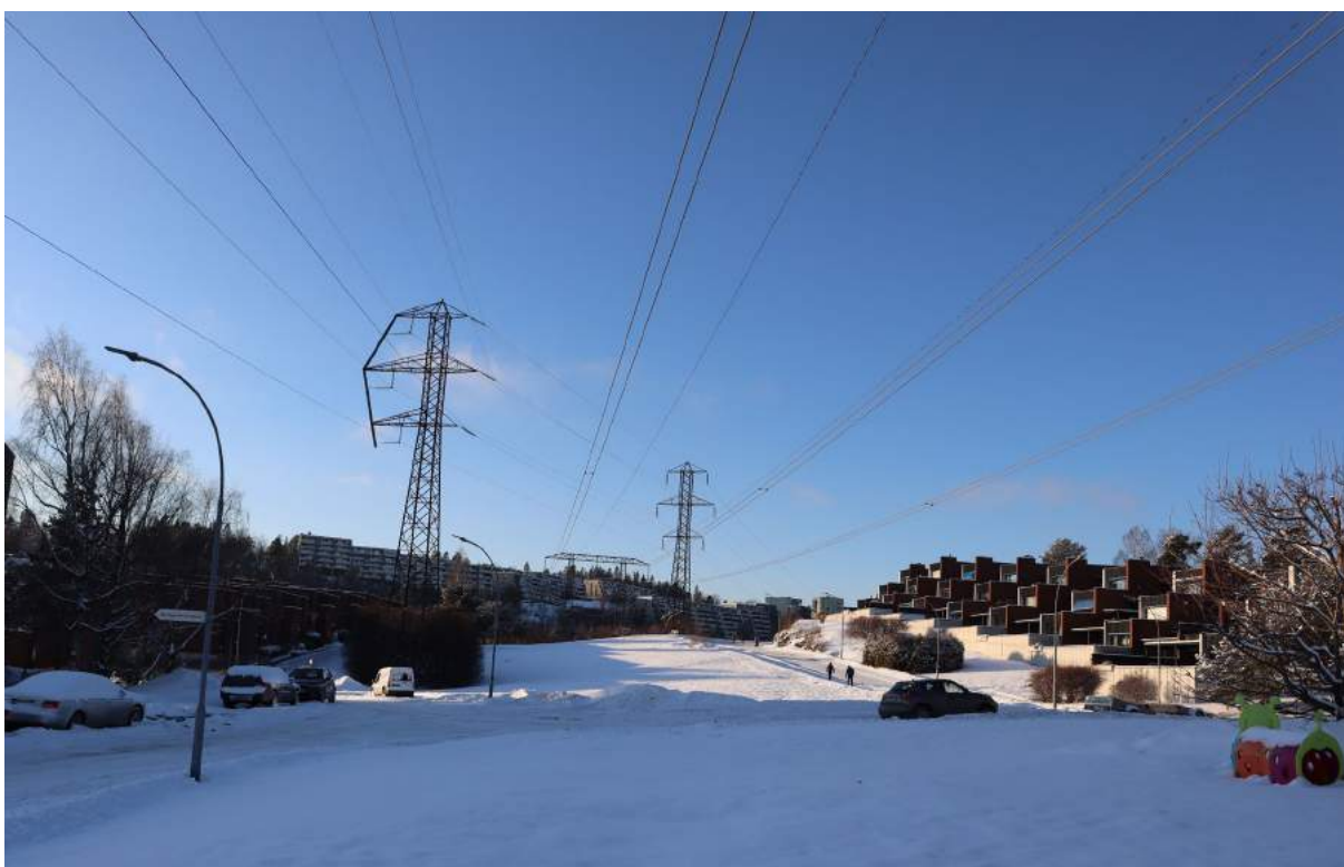
Figur 4-27 Avspenningsmast (nr. 340) på Noreledningen til venstre i bildet. Legg merke til den assymetriske plasseringen av traversene – en løsning som gav vinkelmastene et "rent forrykt utseende" ifølge konstruktøren, J. C. Holst. Ledningen krysser 300 kV-ledningen L0443 fra Bærum. Foto fra Mærradalen nordvest for Smestad transformatorstasjon.
