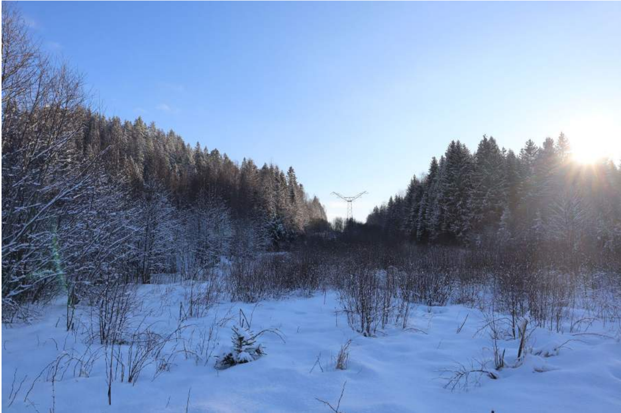
Figur 4-23 Mast nr. 315 som skal bevares i terrenget sør for Wyllerløypa. Her allerede befridd for linene.
