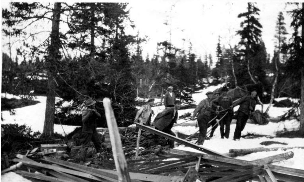
Figur 5-2 Drar fram redskap til mast 49: 4. juni 1927. Kilde: Statnett
