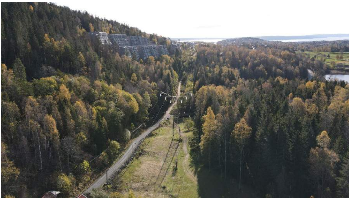
Figur 4-26 Traséens overgang mellom landbrukslandskapet i Sørkedalen og tettbebyggelsen ved Bogstad/Voksenåsen. Ledningens siste englemast (nr. 322) står nærmest. Herfra til Smestad bæres linene av de smalere tårnmastene. Foto mot syd.
