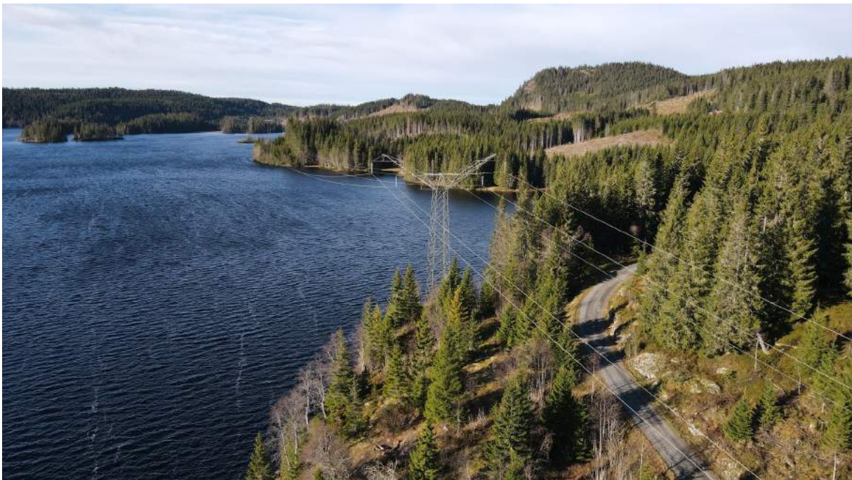
Figur 4-18 Ledningen mellom Krokskogen og Nordmarka langs østsiden av Søndre Heggelivatn. Mast i forgrunnen er nr. 282 (jf Figur 4-17 over). Foto mot nordvest.
