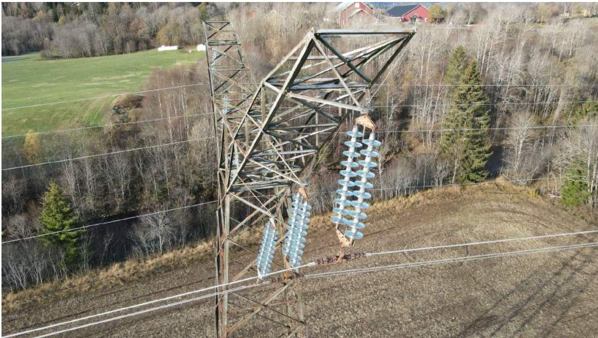
Figur 4-43 Mast nr. 308 med doble isolatorkjeder og (antatt) originale bølgeklemmer.
