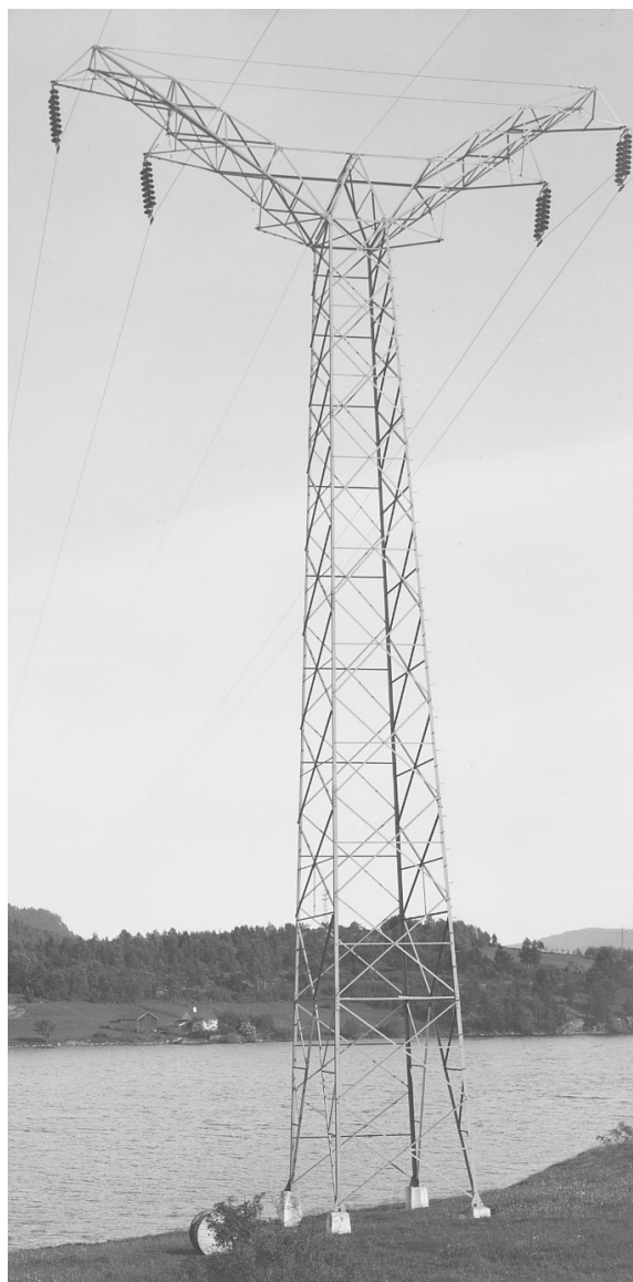
Figur 4-31 Englemast fra Tønsberg-ledningen med doble isolatorkjeder og toppline. Kilde: DigitaltMuseum (A. B. Wilse, 1929)
