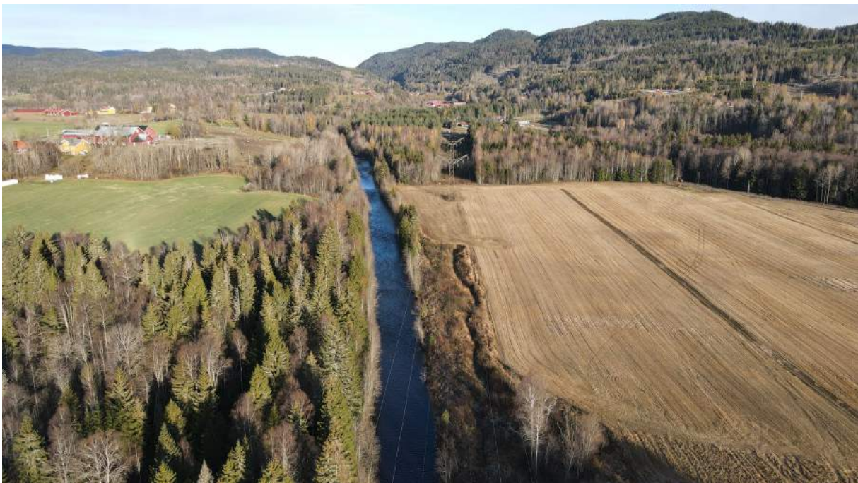
Figur 4-21 Ledningen sett nordover i Sørkedalen. Mast nr. 308 (total mastehøyde 26,2 meter) nærmest i bildet.
