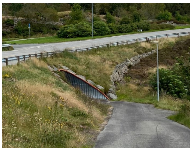
Figur 3: Bildet viser eksisterende tørrmur som støtter opp Blomvågveien, sett mot øst. Kilde: Sweco, 2023
