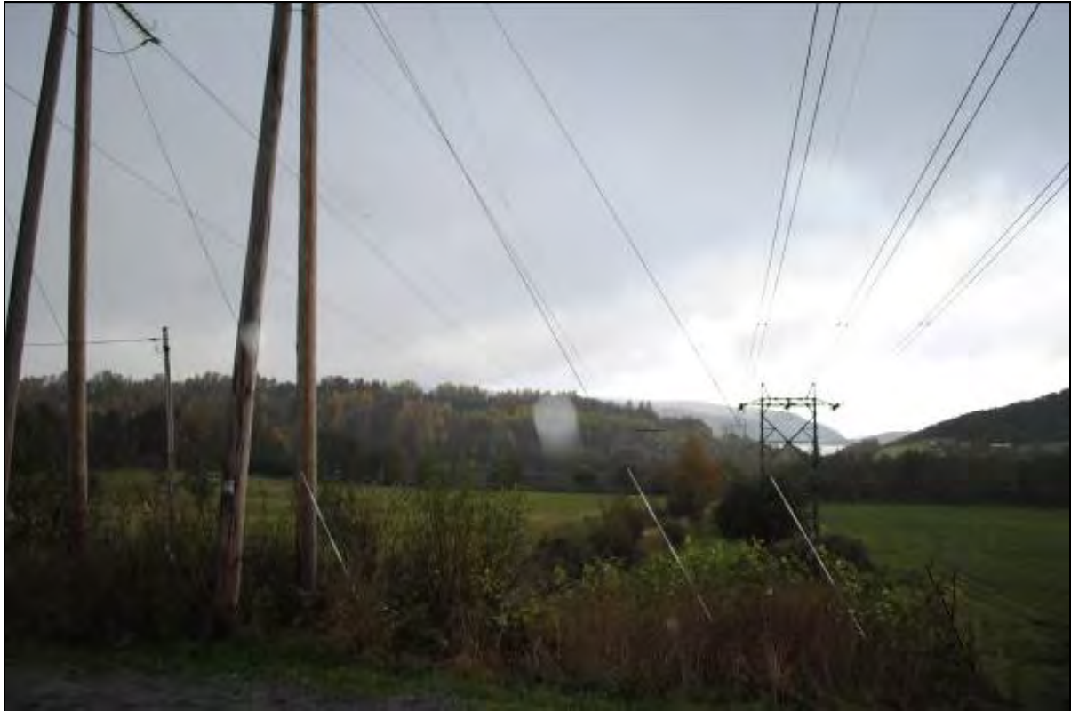
Figur 79 Ås med gravminner, og eksisterende linjer i området, sett fra eksisterende Hemne trafostasjon. Foto: NIKU.
