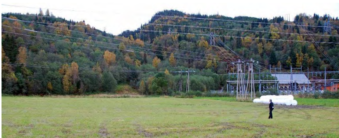
Figur 56. Område for utvidelse av Blåsmo transformatorstasjon.
