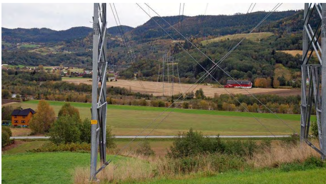
Figur 46. På strekningen inn mot Blåsno transformatorstasjon vil ledningen spenne over viktige jordbruksområder.
