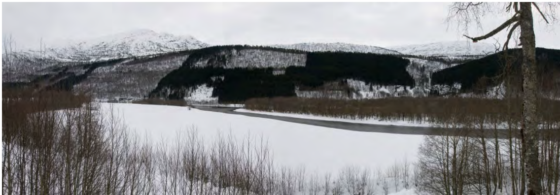
Figur 82. Sammensatt panorama fra Trollheim. Den nye sentralnettsstasjonen vil bli liggende på brinken litt til venstre for midten av bildet. Adkomstveien vil komme opp i skaret til venstre. Foto: Einar Berg.
