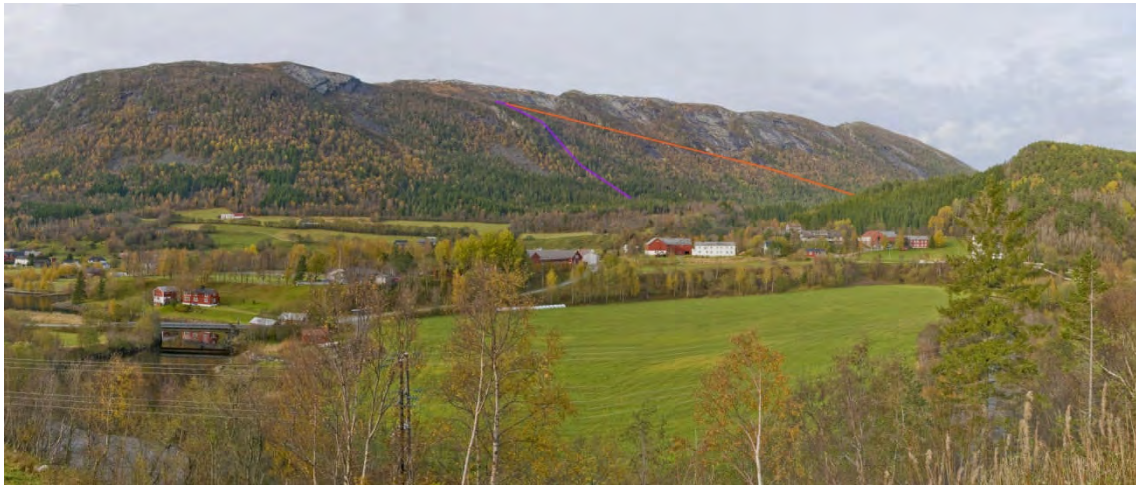
Figur 74. De to aktuelle traseene fra Svarthammaren til Snillfjord. Oransje strek viser ny dobbeltkurstrasé til ny Snillfjord A eller B transformatorstasjon. Fiolett strek viser ny enkeltkurstrasé i dagens 66 kV-trasé til Krokstadøra transformatorstasjon. Foto: Einar Berg
