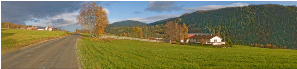
Figur 60. Songdalen. Kryssingen vil skje mellom huset i forgrunnen og gården i bakgrunnen. Opp lia på motsatt side blir det en eksponert ryddegate. Foto: Einar Berg
