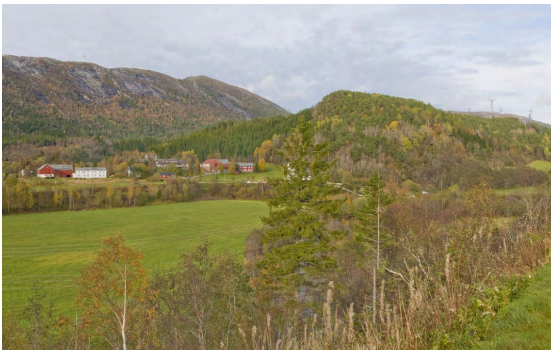
Figur 76: Nettilknytning til Hitra/Svarthammaren/Pållifjellet/Engvikfjellet med innføring til Snillfjord B transformatorstasjon(alternativ 1.0) sett fra Snillfjord omsorgssenter. Foto: Einar Berg. Visualisering: Katrine Lone Bjørnstad.
