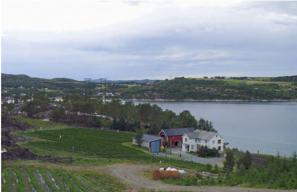
Figur 65. Malnes. Som vist på bildet kommer det her et nytt høyt spenn parallelt med det eksisterende. Samtidig får man revet det eldste spennet over sundet. Dette ligger utenfor billedutsnittet på høyre side. Se Figur 72. Foto: Svein Erik Dahl. Visualisering: Einar Berg
