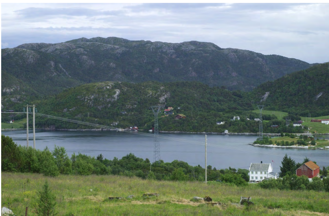
Figur 72. Malnes. Ledningen som går på spenn med stålmaster over sundet kan rives. Se også Figur 65. Foto: Svein Erik Dahl
