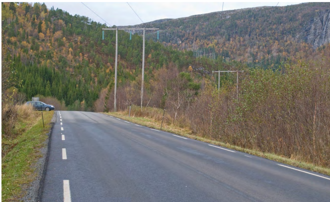
Figur 73. Byrvollan nord for Krokstadøra. Ledningen til høyre er 66 kV-ledningen fra Fillan til Krokstadøra som planlegges sanert. Foto: Einar Berg
