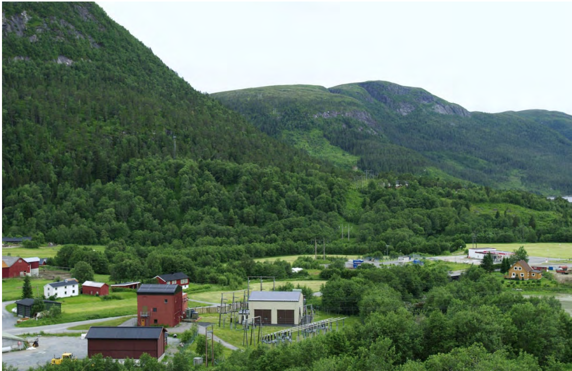
Figur 81. Nåværende Krokstadøra transformatorstasjon, med utføringskorridor mot Aunsætra og Geitfjellet. Ledningen går tett inntil byggefeltet på Krokstadøra. Det vil være en fordel å få sanert denne ledningen. Foto: Svein Erik Dahl.
