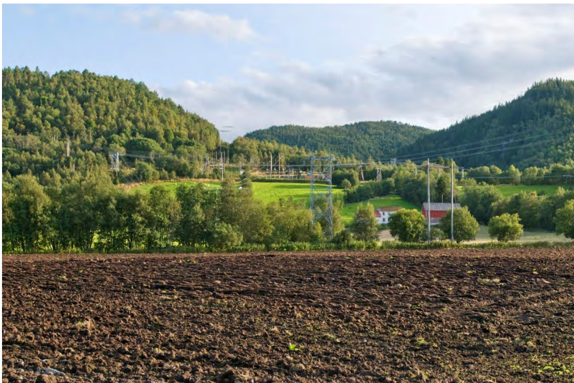
Figur 70. Holla. De to aktuelle ledningene som kan saneres sees i forgrunnen av bildet: 22 kV-ledningen på stålmaster til venstre, og 132 kV-ledningen på trestolper til høyre. Foto: Einar Berg
