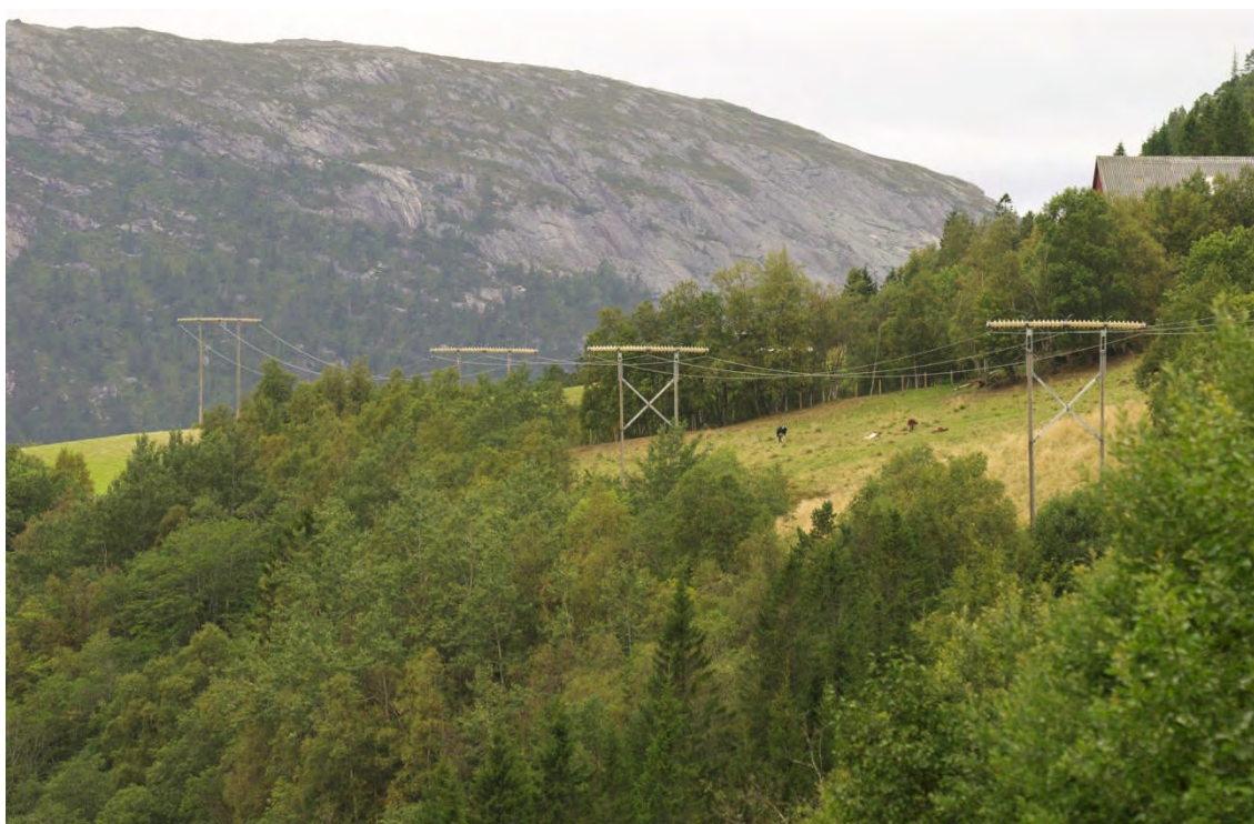
Figur 85. Sætergardsdalen. Kryssavstivingene og isolatorene i traversen gjør disse mastekonstruksjonene mer iøynefallende.
