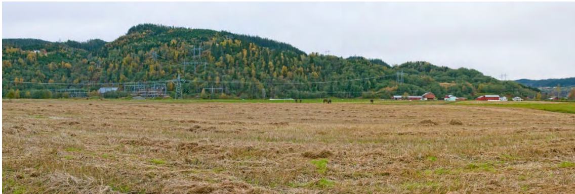
Figur 63. Orkdal transformatorstasjon på Blåsmo. Det er så trangt langs dalsiden at ny ledning må legges i skråningen rett bak gården. Det medfører at kantvegetasjonen snaues med mindre spesielle tiltak gjennomføres. Dette vurderes uheldig både økologisk og landskapsestetisk, og gården får ledningen veldig tett innpå livet. Foto: Einar Berg
