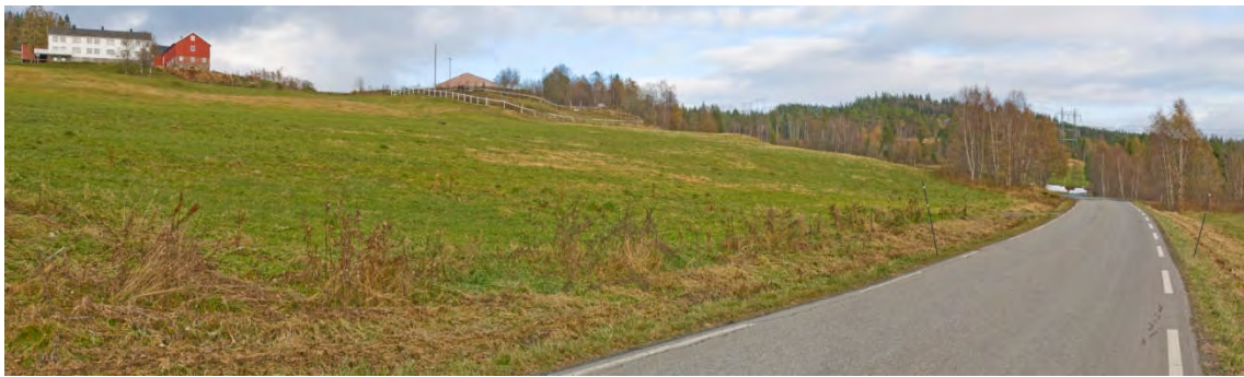
Figur 57. Tomt for ny Orkdal vest transformatorstasjon i bakgrunnen til høyre i bildet. Berge gård til venstre. Foto: Einar Berg
