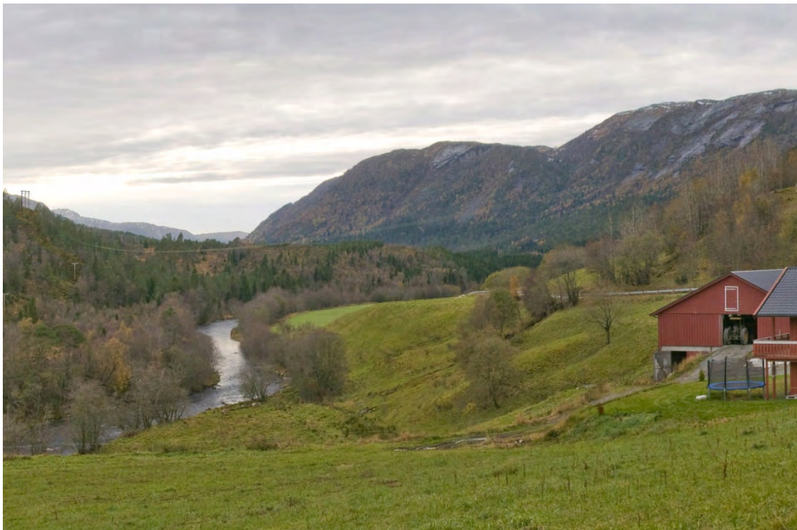
Figur 68: 132 kV-ledningen fra Remmafjellet vindkraftverk til Krokstadøra sett fra Bergslia. Foto: Einar Berg. Visualisering: Katrine Lone Bjørnstad.
