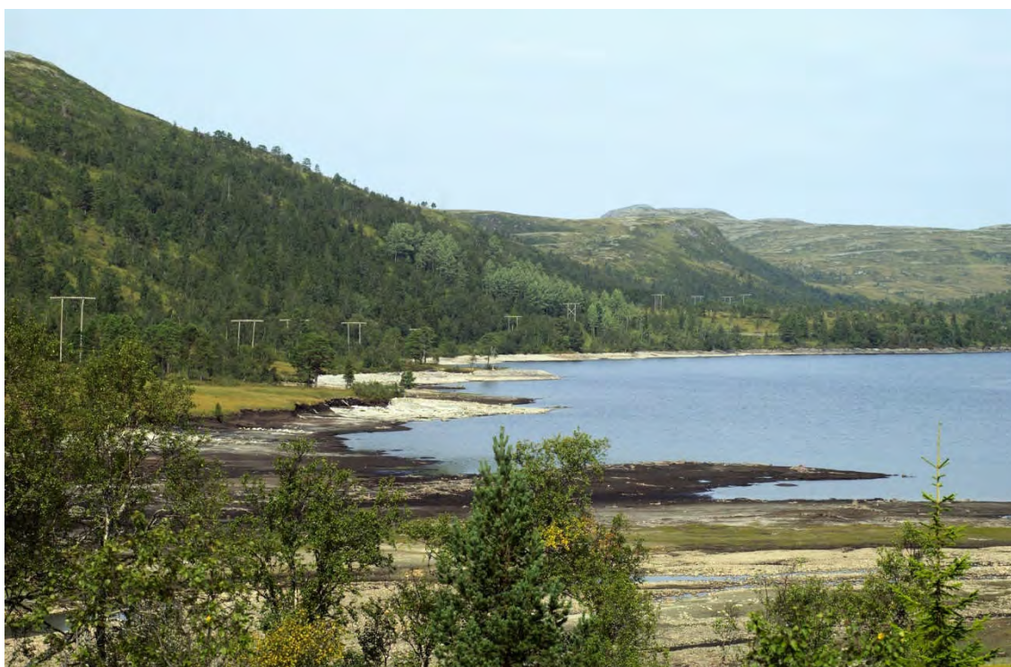
Figur 84. Våvatnet. 132 kV-ledningen går i strandsonen.
