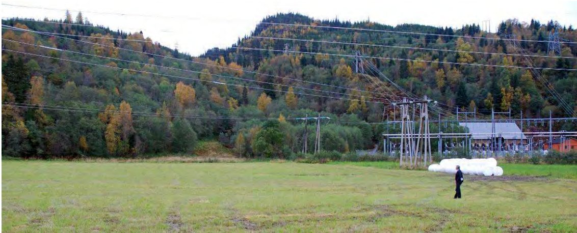
Figur 53. Område for utvidelse av Blåsmo transformatorstasjon.
