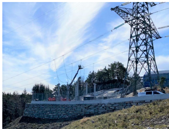
Figur 4: Eksempel på åpent muffeanlegg
