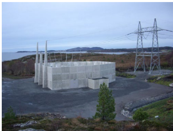
Figur 3: Eksempel på betongsikret muffeanlegg.
