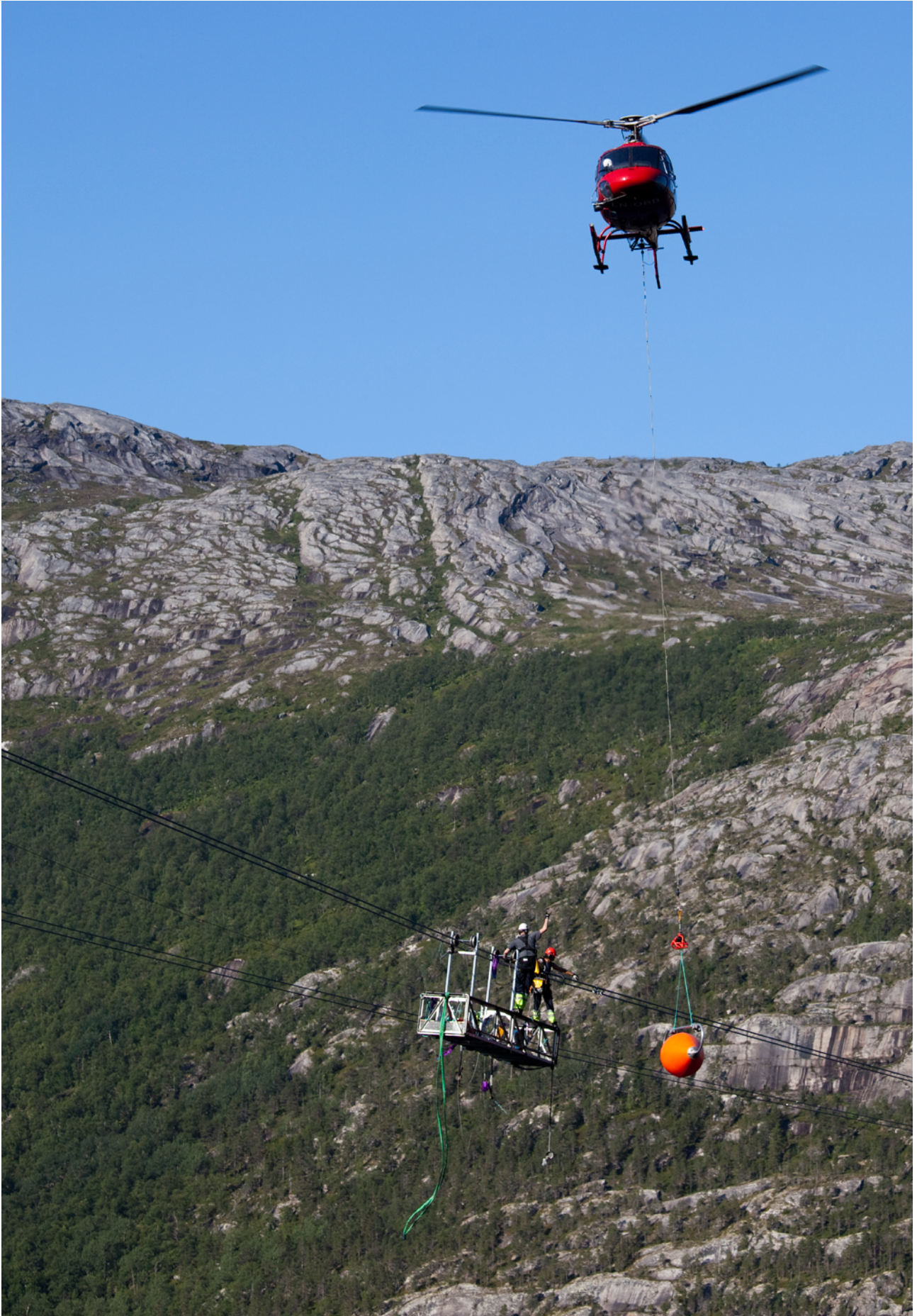
Montasje av flymarkør på fjordspenn.
