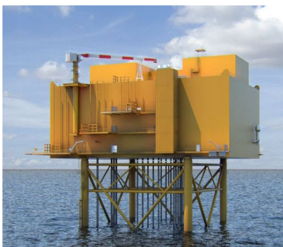
Figur 179: Equinor og Vårgrønns plattform med 1,2 GW og 320 kV symmetrisk monopol omformer uten boligkvarter (Illustrasjon: Aibel).
