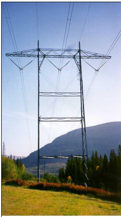
Figur 3. Mast med isolatorkjeder i V-form. Foto: Statnett
