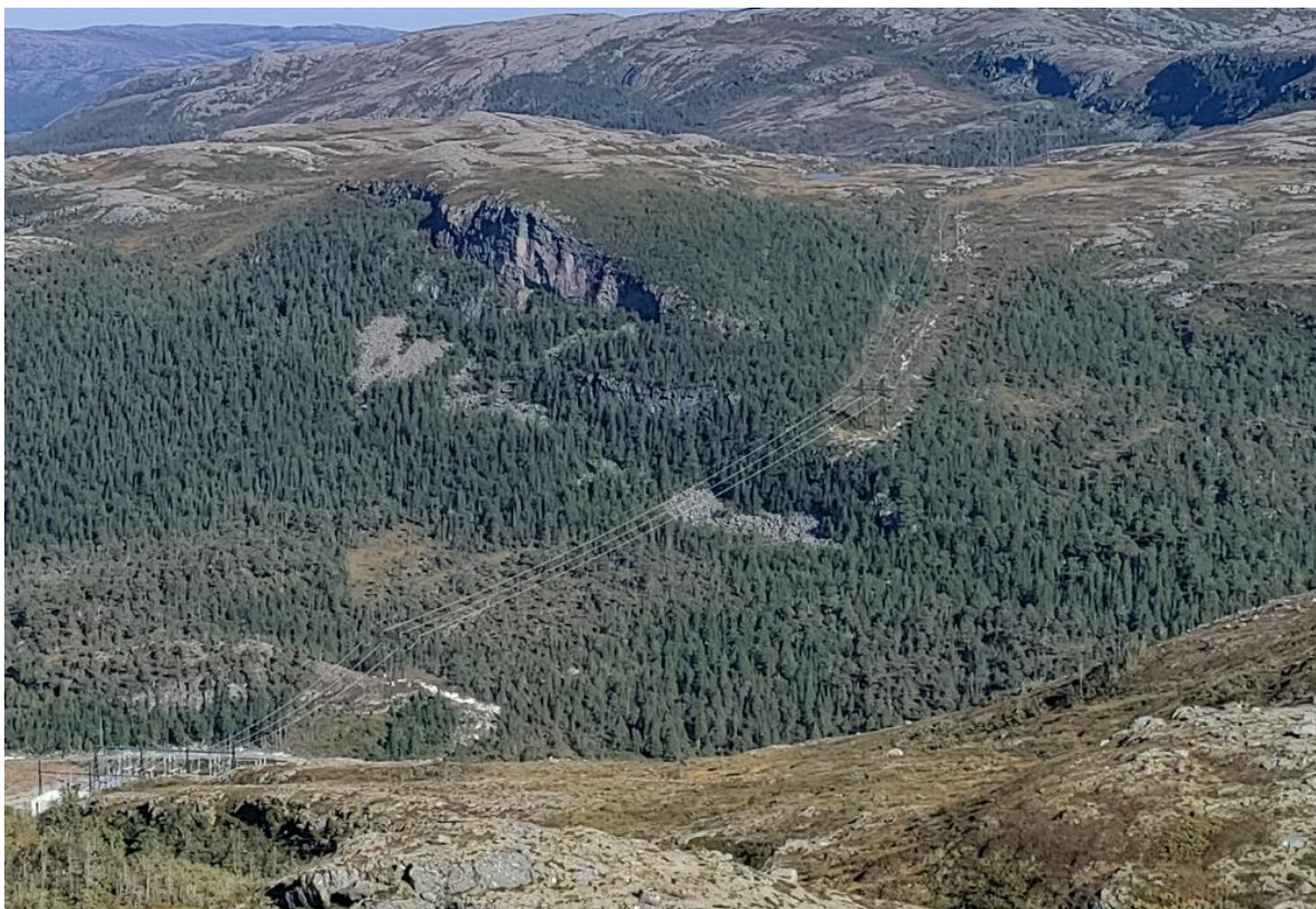
Figur 5-8 Dagens 420 kV-ledning fra Åfjord stasjon og nordover. Sett fra Storheia. Under befaring kunne man se at det fortsatt var «arr» i terrenget etter feltkjøretøy enkelte steder i ledningstraseen til eksisterende 420 kV-ledning.
