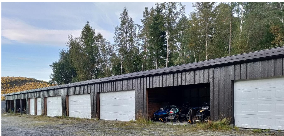
Figur 5-2 Skutergarsje langs Fessdalsveien, ved «inngangen» til Fessdalen. Blir brukt for transport til og fra hytter.
