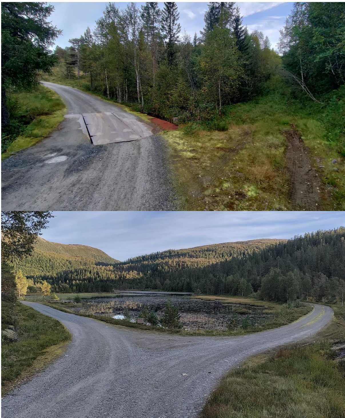
Figur 5-4 Bildene over er fra område C (Figur 5-3). Øverste bildet viser hvordan veien krysser bekken, samt drivleia videre ut i terrenget. Fremkommelighet her er viktig ikke endres. Nederste bildet viser begge veier hvor driv foregår langs Langvatnet. Her er det viktig at lagringsplasser etc. ikke endrer terrenget. I driftsperioden vil det være viktig at eventuelle oppgraderinger av veien ikke har gjort det mulig å holde den vinteråpen (at den kan brøytes), og spesielt ikke tilrettelegge for parkering etc.
