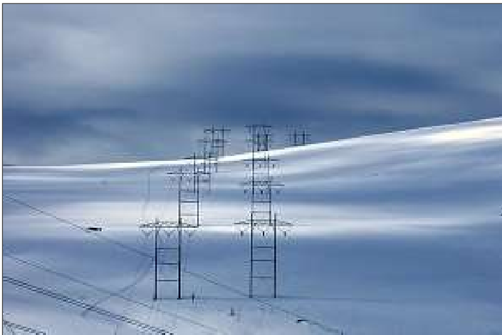
Figur 39: Parallell traséer oppfattes gjerne som mest ryddige når man har samme mastetype.
