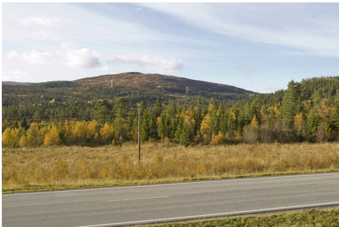
Figur 28. 420 kV-traseen går rett fram og til dels lavere i terrenget. Hvis traseen hadde knekket rundt fjellkammen, ville ytterligere 1 – 2 master blitt synlige herfra. Foto og visualisering: Einar Berg
