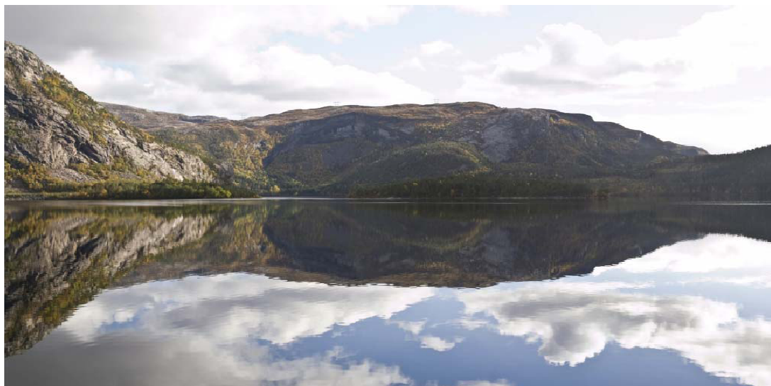
Figur 10. 420 kV-ledningen over Kjelbotnheia mot Storheia transformatorstasjon sett fra Blåbærlyngen. Foto og visualisering: Einar Berg.
