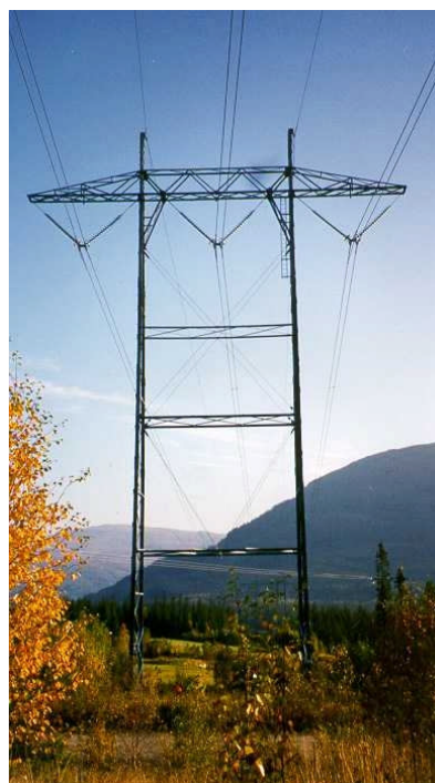
Figur 2. Figuren viser mastebilde for konsesjonssøkt 300(420) kV-ledning. Ledningen er tenkt bygget med selvbærende master. Masten vil ha et byggeforbudsbelte og ryddebelte i skog på ca. 40 meters bredde.
