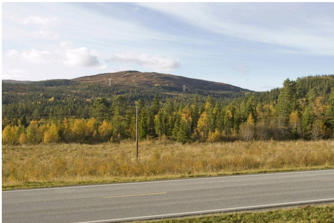
Figur 4. 420 kV ledningen ligger noe lavere i terrenget enn traseen til eksisterende 66 kV-ledning. Foto og visualisering: Einar Berg.
