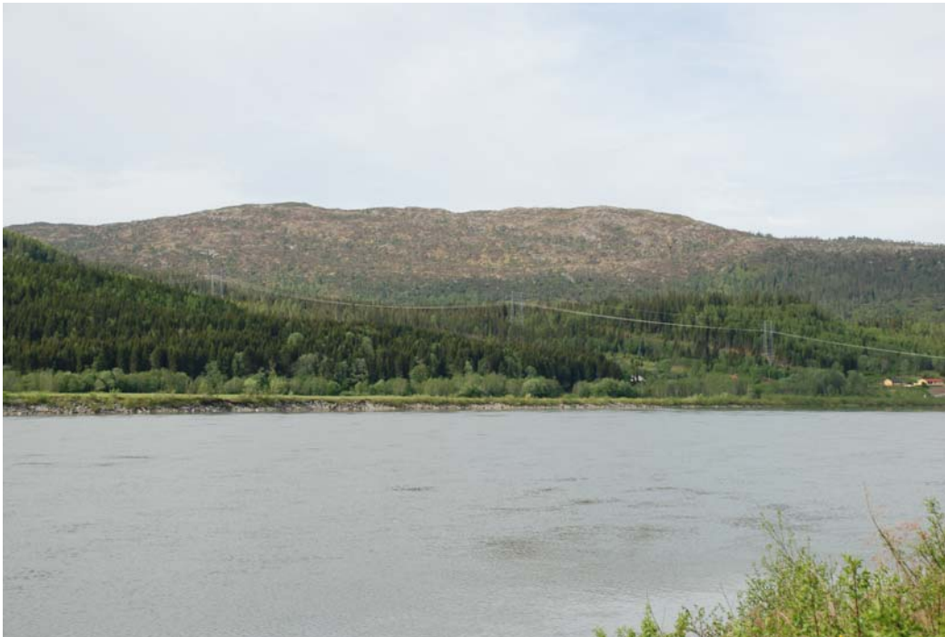
Figur 5. Namsen renner bred og rolig nede i dalbunnen med skogkledde åser rundt. Her fra Overhalla mot Horken. Eksisterende 300 kV går midt i bildet. Ny 420 kV vil gå parallelt med denne. I konsesjonssøknaden er en parallellføring visualisert (Foto: Asplan Viak).
