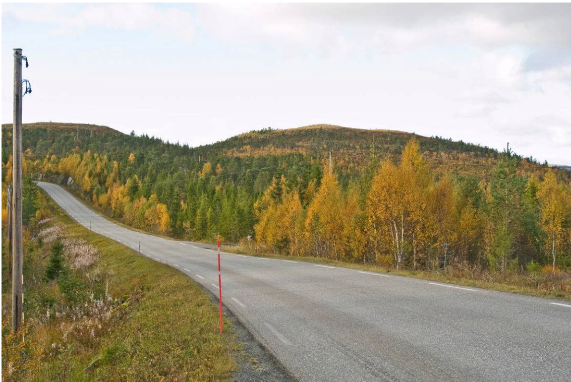
Figur 1: Roan transformatorstasjon vil bli liggende skjult bak Haugtjønklumpen som sees i bakgrunnen i bildet. Foto: Einar Berg
