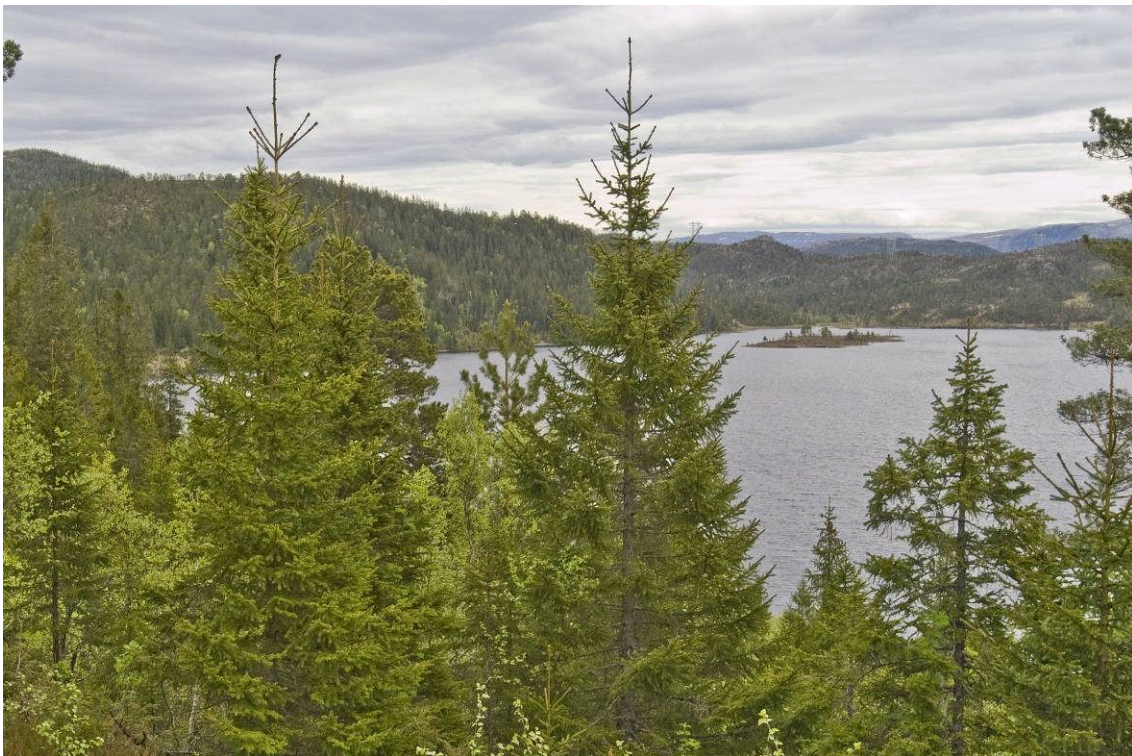
Figur 11: 420 kV-ledningen sett fra hytteområdet i nordenden av Berdalsvatnet. Mastene rir mer på toppene enn dagens 66 kV-ledning. Foto og visualisering: Einar Berg
