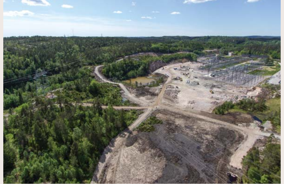
Figur 43 I noen tilfeller kan det, som her ved Kristiansand transformatorstasjon, være nødvendig å så for å stabilisere deponiet av myrmasse så fort som mulig.
