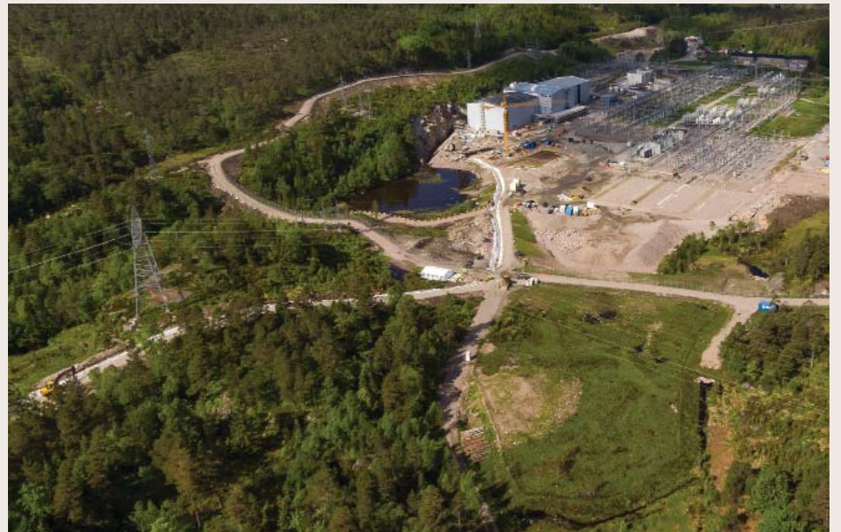
Figur 44 Etter én vekstsesong er vegetasjonsetableringen godt i gang. I områdene med minst organisk materiale på toppen er det naturlig nok fortsatt noe skrint.
