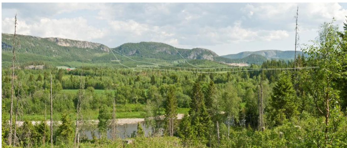
Figur 21. Illustrasjonen viser de tre alternativene 3.0, 3.1.2 og kombinasjonsalternativet 3.1.3 ved kryssing riksvei 17 ved Namdalseid.
