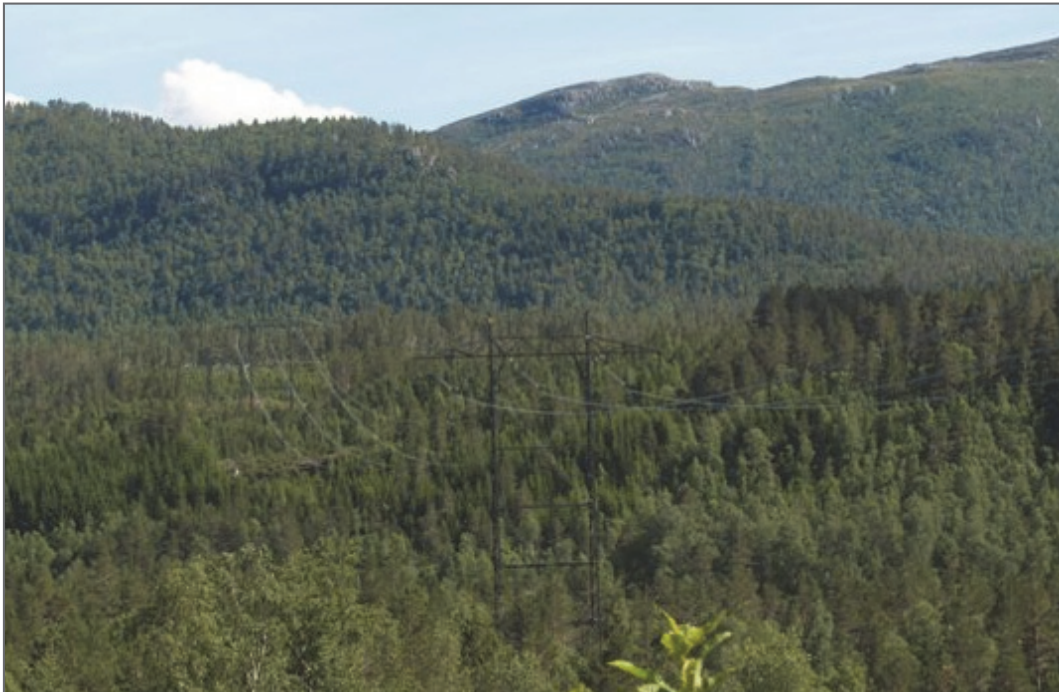
Figur 22: Bilde av kamuflert kraftledning.
