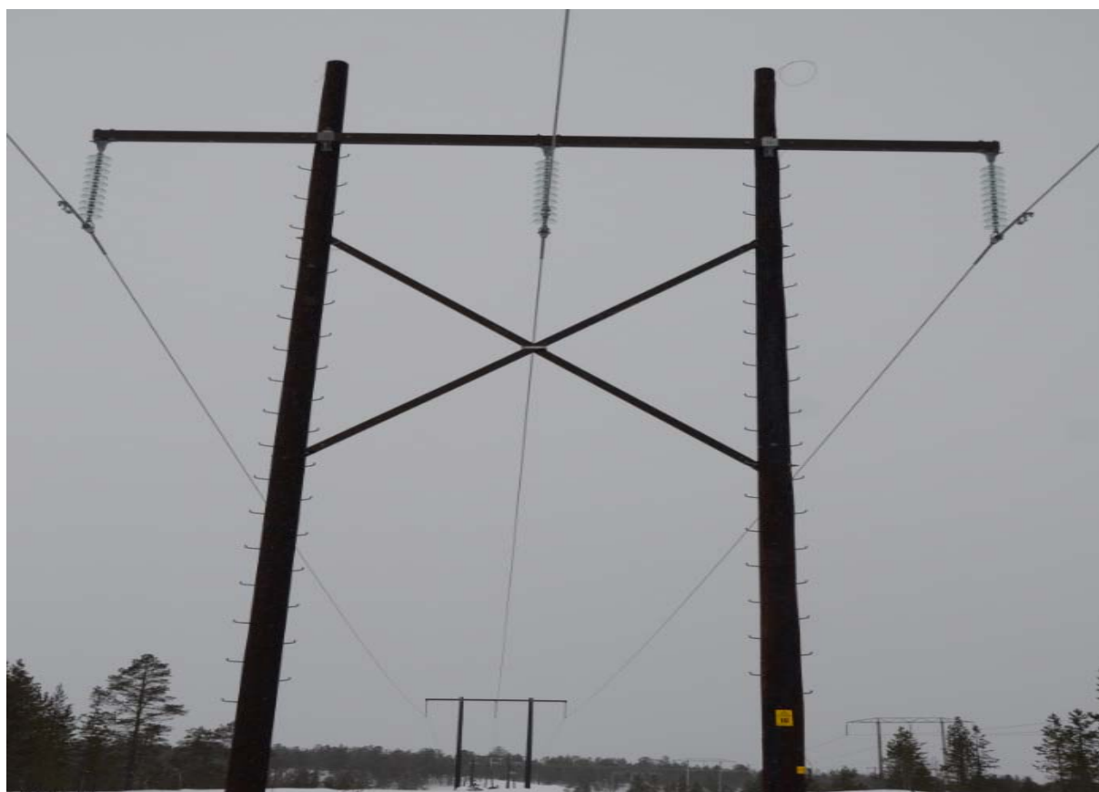
Figur 3. BM (Bæremast)- Rundtømmermast
