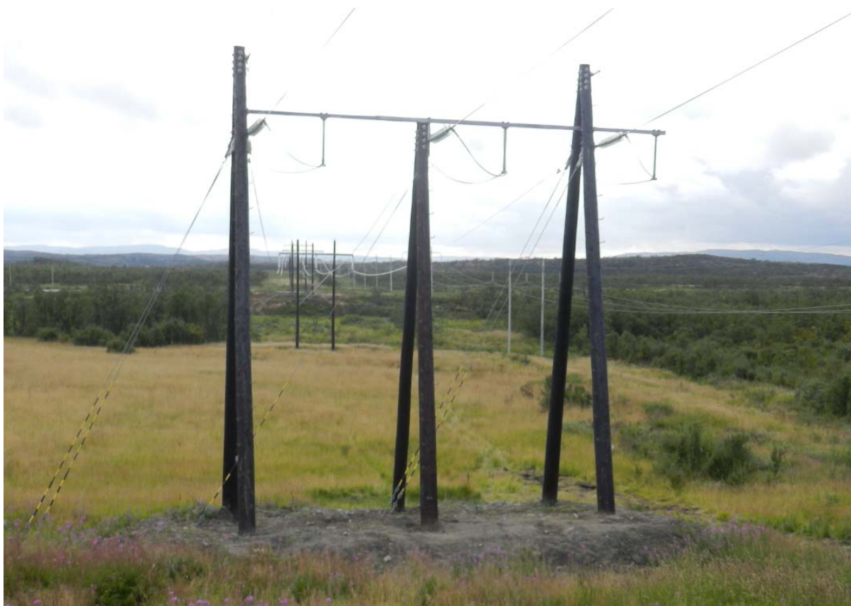
Figur 1. FMV (forankringsmast) – rundtømmermast
