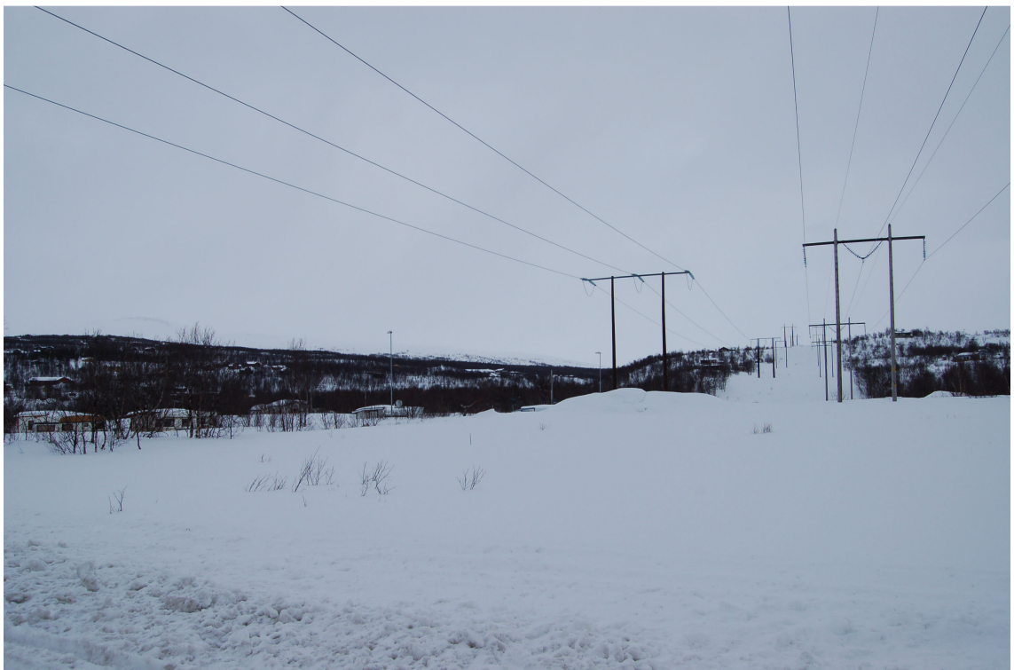
Figur 7-1: Ryddegate under eksisterende kraftledning ved Skaidi
