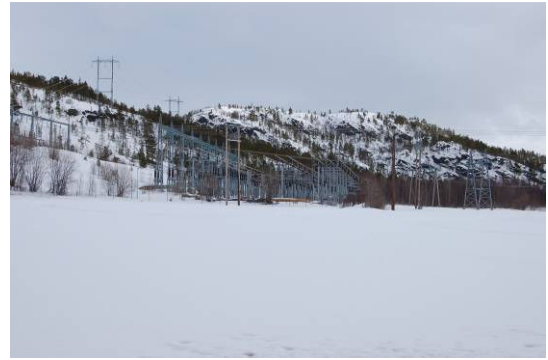
Figur 5-6: Dyrket jord rundt Raipas transformatorstasjon
