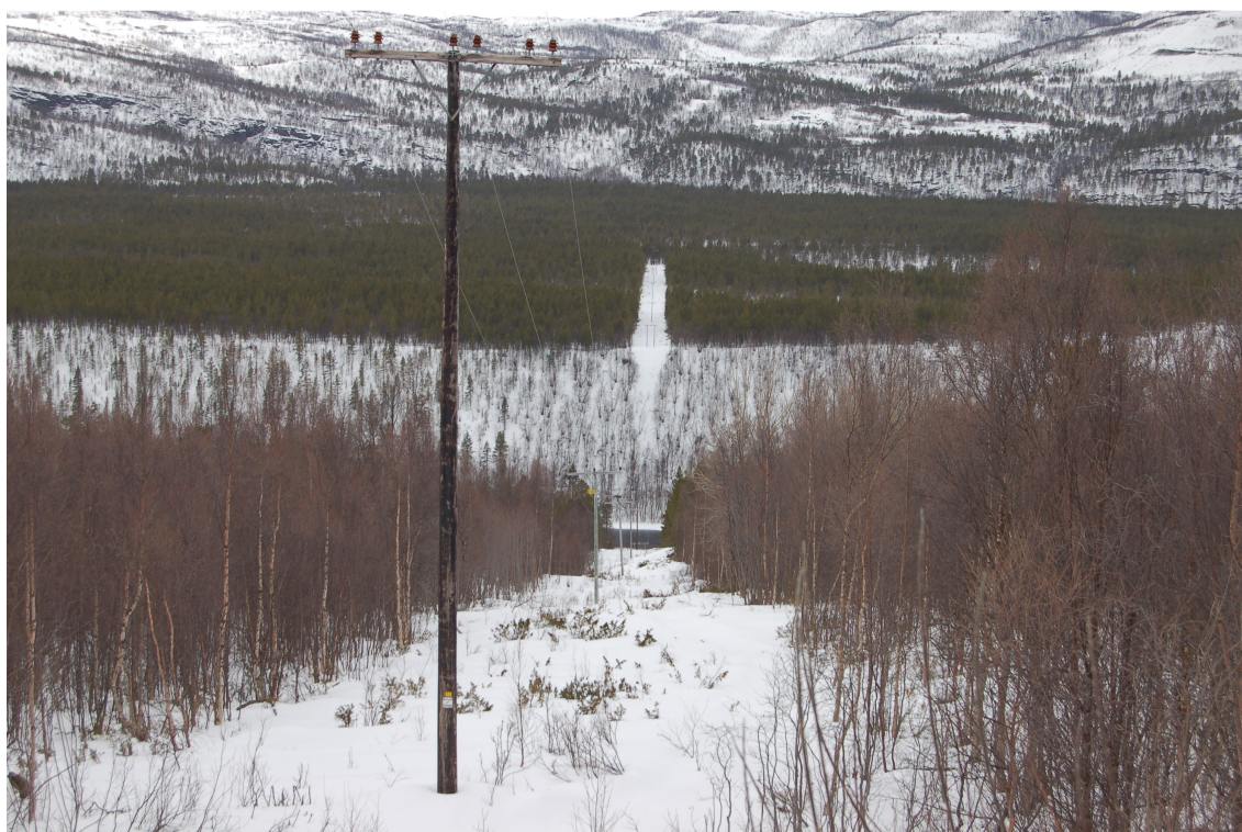
Figur 5-1: Selv små ledninger fører til store ryddegater. Fra Alta
