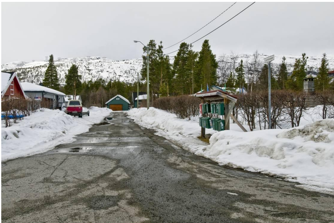
Figur 10: Nedføringen mot Skillemoen transformatorstasjon i konsesjonssøkt alternativ. Endret plassering vil kunne endre noe på mastebildet i nedre del av fjellsiden, men dette traséavsnittet er stort sett skjult bak trærne i forgrunnen.
