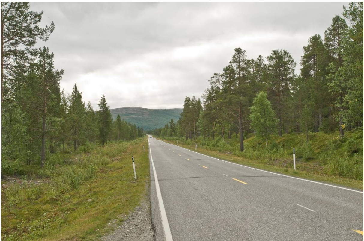
Figur 70: Eibymoens transformatorstasjon vil eventuelt bli liggende i skogen til høyre for riksveien omtrent midt på denne sletta. 420 kV-ledningen mot Skaidi vil krysse rett over veien i samme område. Foto: Einar Berg
