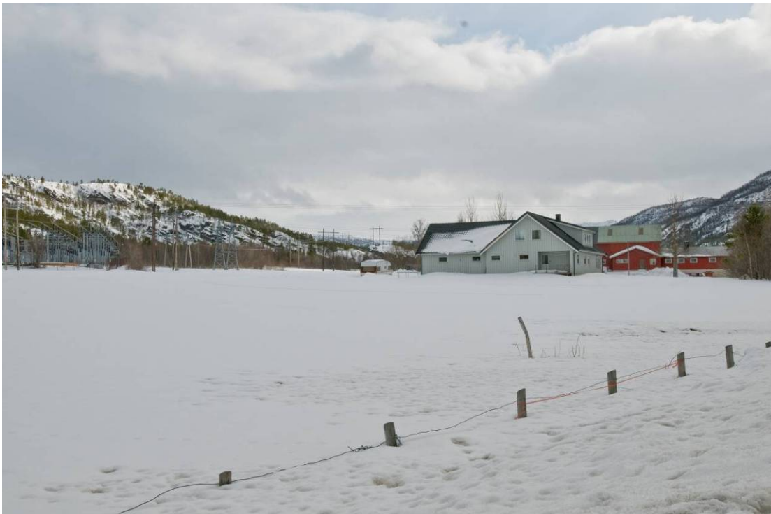
Figur 75: Innføringskorridoren sørover ved Raipas transformatorstasjon. Her blir situasjonen i det store og hele uendret. Foto: Einar Berg
