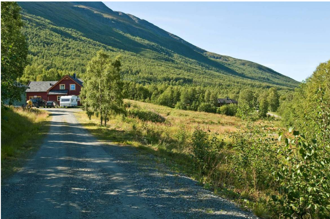
Figur 32: Stedvis vil ledningen langs Balsfjorden gå både relativt nær og relativt eksponert mot bebyggelse, for eksempel her ved Bjørnebu. Eksisterende 132 kV-ledning ses i bildet. Foto: Einar Berg
