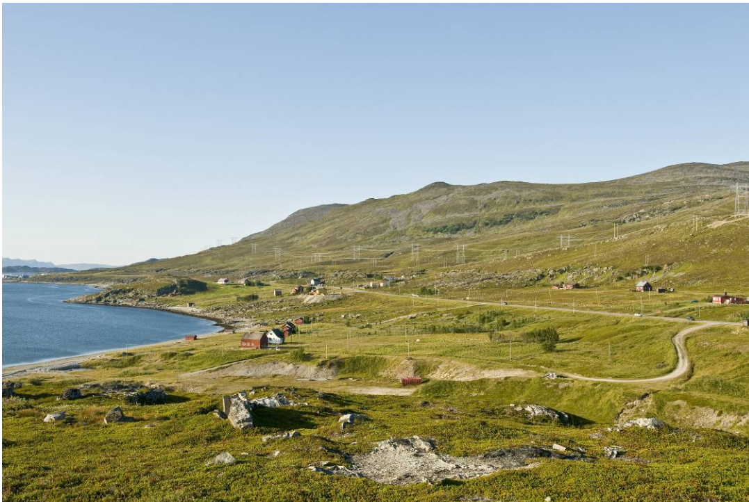
Figur 90: Fra Elveneset mot Skjåholmen. Masterekkene går i et svært åpent landskap tett inntil bebyggelsen. Ny 420 kV-ledning her vil bli visuelt dominerende. Foto: Einar Berg
