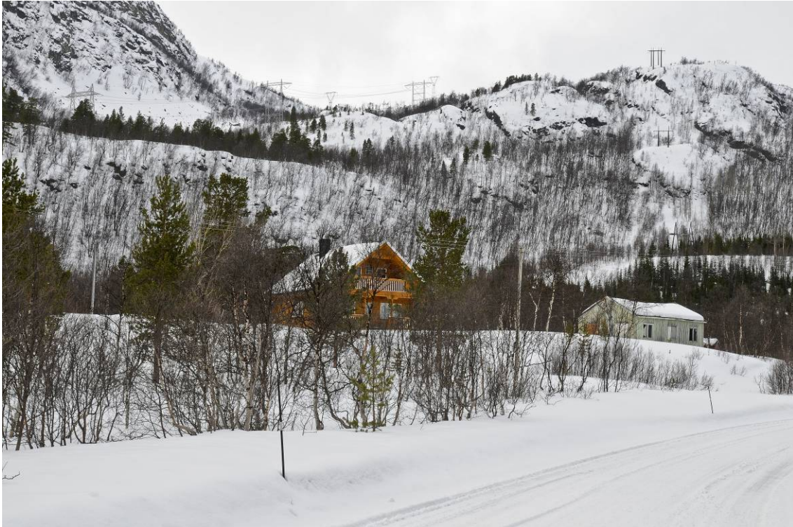
Figur 58: Naviteidet. I alternativ 1.20 kommer 420 kV-ledningen ned dalen i dette området sammen med de eksisterende 132 kV-ledningene. Situasjonen kan bli rotete og påtrengende. Foto: Einar Berg
