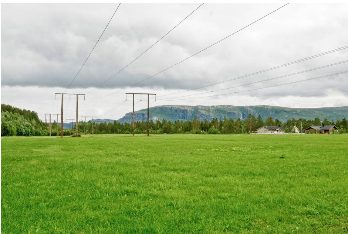
Figur 71: De to eksisterende 132 kV-ledningene til Raipas går i en korridor temmelig nær bebyggelsen på Skillemo. Selv om den eldste av dem saneres, blir situasjonen visuelt sett uendret her dersom Alta Kraftlag bygger sin nye planlagte 132 kV-ledning fra Skoddavarre til Eibymoens transformatorstasjon. Foto: Einar Berg
