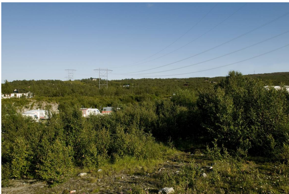
Figur 83: Skaidi. På dette partiet ligger hyttene kloss innpå ledningskorridoren, og kablingstiltak tvinger seg frem hvis det skal bli plass til ny 420 kV-ledning. Foto: Einar Berg
