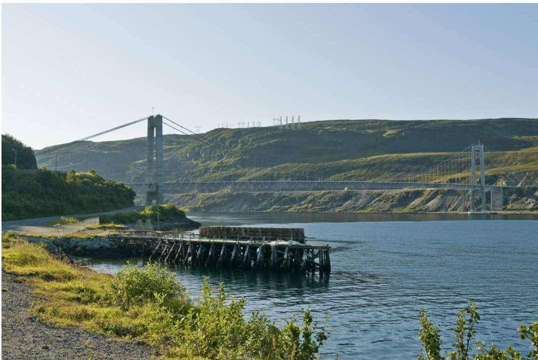
Figur 89: Ved kryssingen av Kvalsundet må 420 kV-ledningen føres ut på avspenningsbukker, som kommer i tillegg til de to settene med slike master som er der fra før. Det bør være mulig å unngå flere markører på linene enn det som er situasjonen i dag. Foto: Einar Berg
