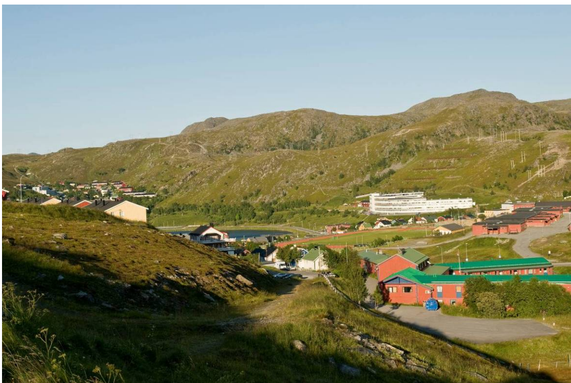
Figur 93: Hammerfest. Tre parallelle 132 kV-ledninger vil i tillegg til stolperekken på lavere spenningsnivå skape masseeffekt og mye visuelt rot. Foto: Einar Berg
