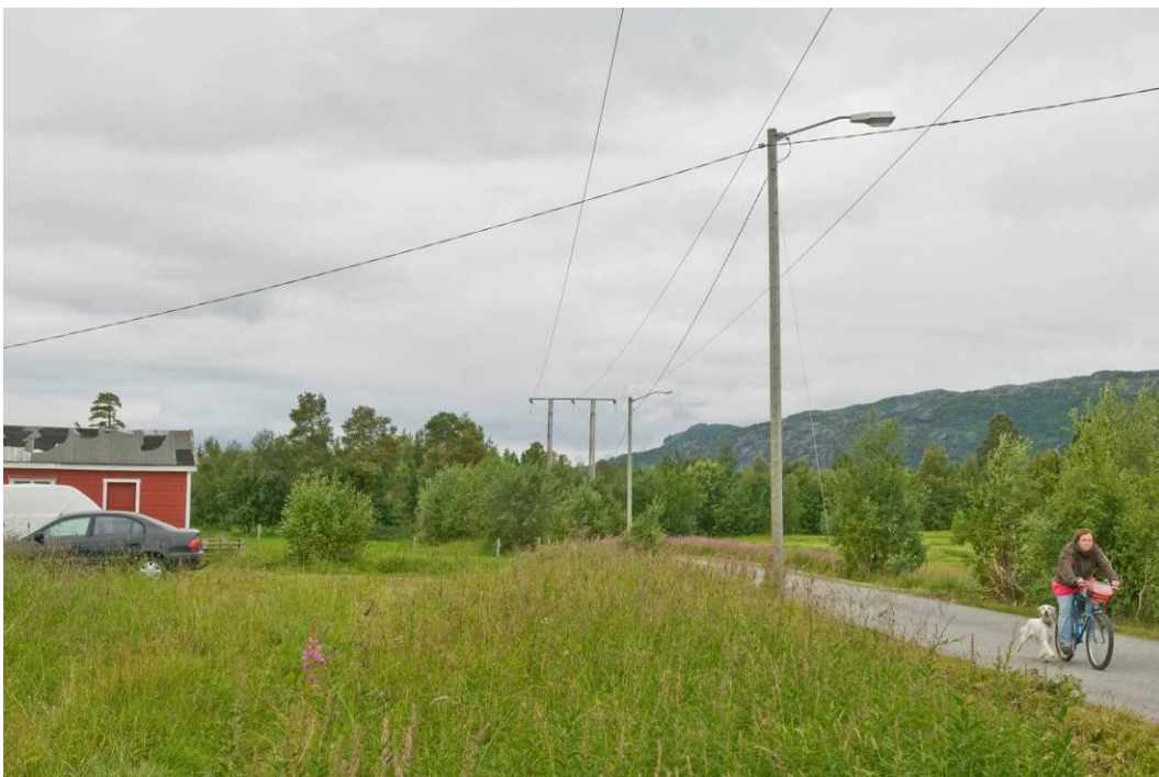
Figur 66: Denne 132 kV-ledningen fra Skillemoen til Raipas blir revet, her ved Øvergård. Det er positivt for de nære omgivelsene ved Øvre Alta, men betyr ellers ikke så mye fra eller til. Foto: Einar Berg
