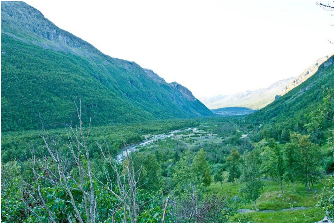
Figur 48: Planlagt ny Kåfjord transformatorstasjon blir liggende i kanten av den skogkledd elvesletten et stykke til venstre og bak for brua som vises midt i bildet. Foto: Einar Berg
