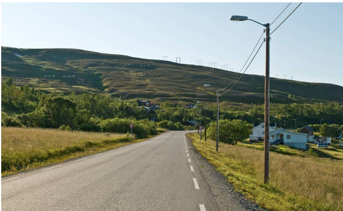
Figur 86: Gårgu - Sletteiv. Ledningene danner en kraftig silhuett i det treløse, åpne landskapet. Foto: Einar Berg
