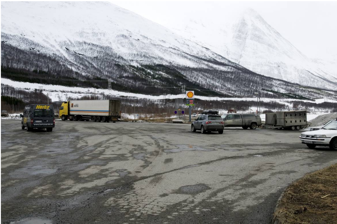
Figur 33: Ryddegaten fremstår som et tydelig bånd et stykke opp i lisen langs Balsfjorden og Nordkjosbotn. Med ny 420 kV-ledning i tillegg vil "båndbredden" øke betydelig. Foto: Einar Berg
