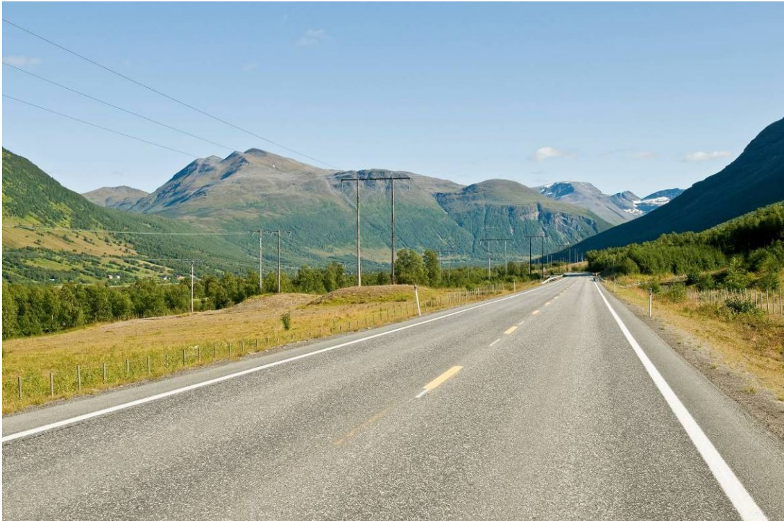
Figur 31: På deler av strekningen inn mot Nordkjosbotn kan det bli opptil fire parallelle ledninger. Foto: Einar Berg
