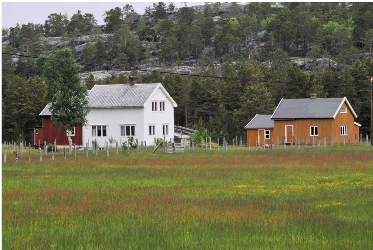
Figur 41: Et småbruk i gjenreisningstidens byggeskikk, Kvænangsbotn. Foto: Elin Rose Myrvoll 2008.
