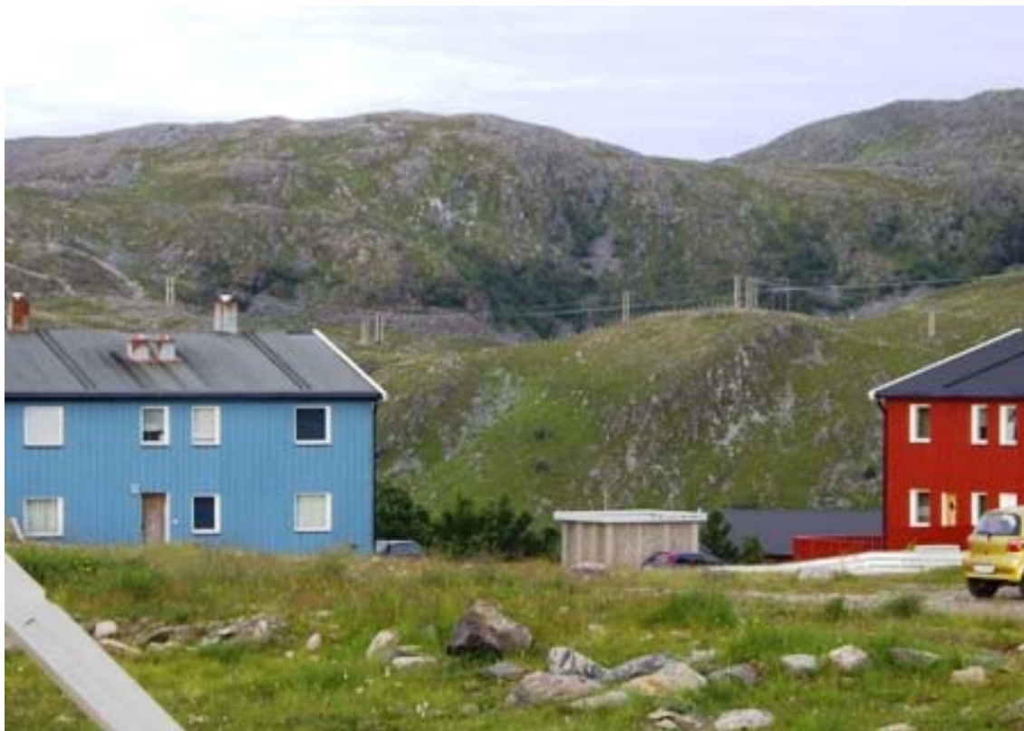
Figur 6.8 b: Gjerdet rundt Hammerfest by går delvis parallelt med dagens ledninger. Ny ledning bør gå på innsiden av gjerdet
