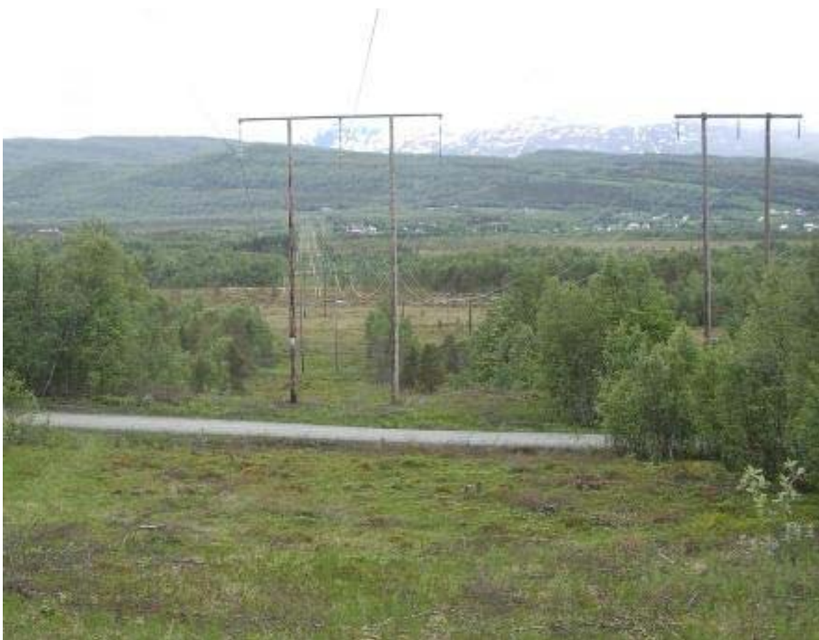
Figur 6.1: Dagens ledningstrase sett fra foten av Høltinden og mot Balsfjord trafostasjon. På midten av bildet ses myrene som blir brukt tidlig vinter av distrikt 27 Mauken/Tromsdalen.
