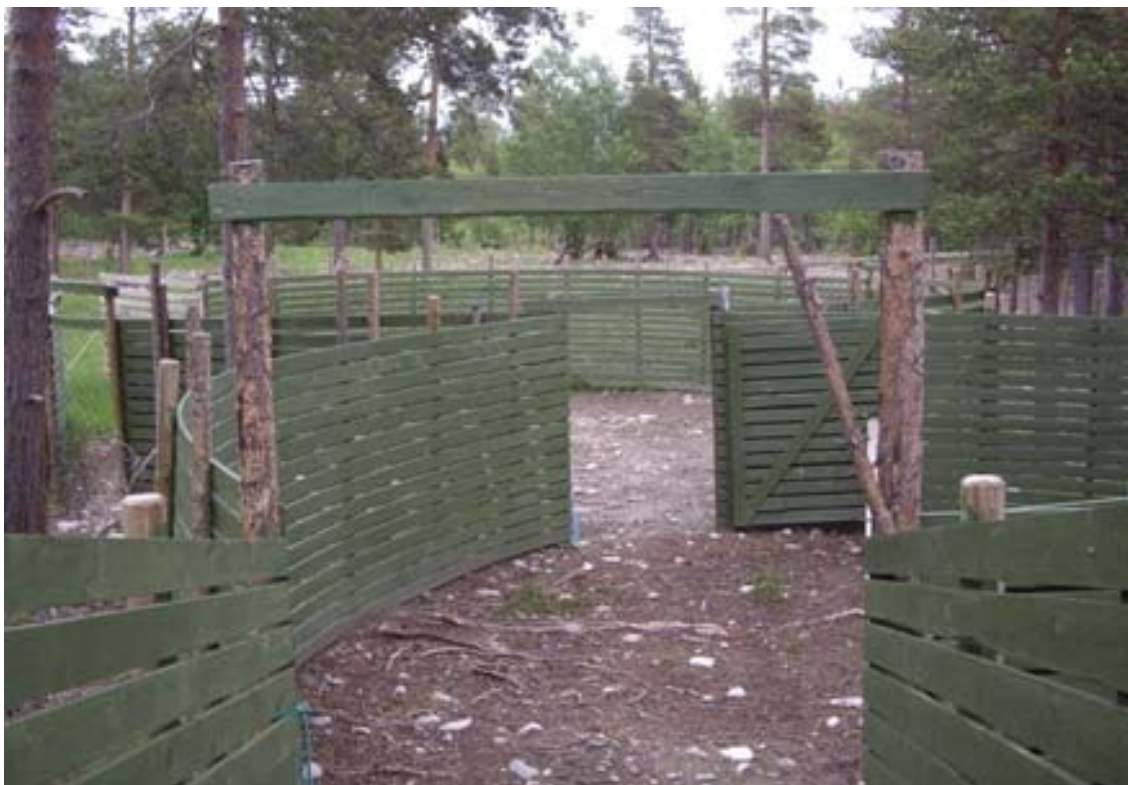
Figur 6.5 f: Slakte og merkegjerdet til distrikt 25 ved Storvatn. Gjerdeanlegget ligger like i nærheten av alt 1.0
