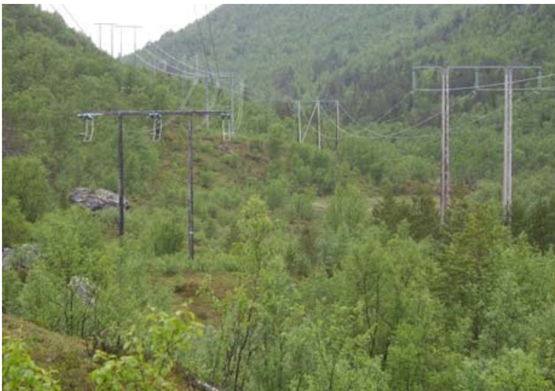
Figur 6.5 e: Flyttlei langs dagens ledninger rett nordvest for Nållovårri. Brukes av de distrikter som flytter til og fra Kvenvik
