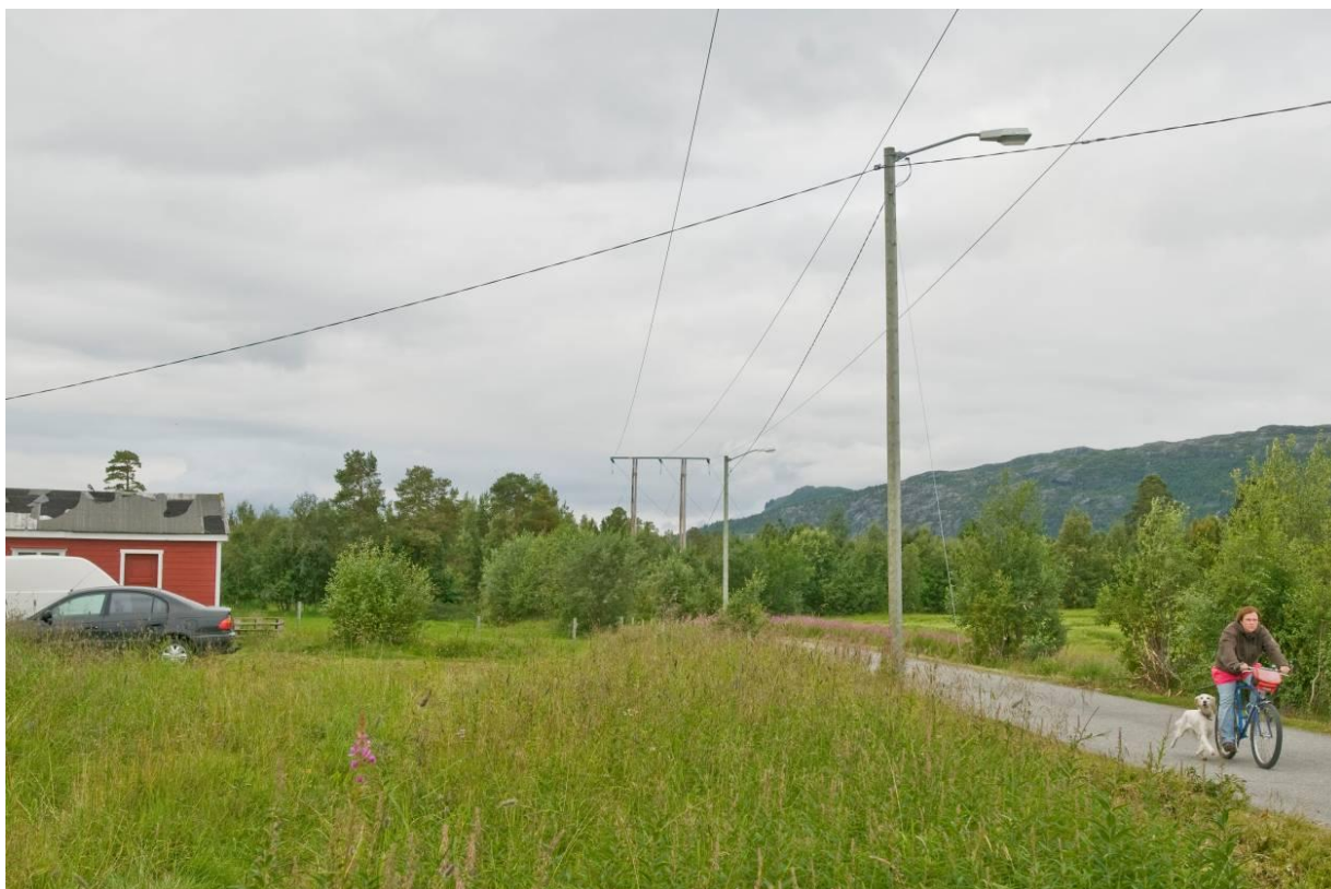
Figur 15: Denne 132 kV-ledningen fra Skillemoen til Raipas blir revet, her ved Øvergård. Det er positivt for de nære omgivelsene ved Øvre Alta, men betyr ellers ikke så mye fra eller til. Foto: Einar Berg
