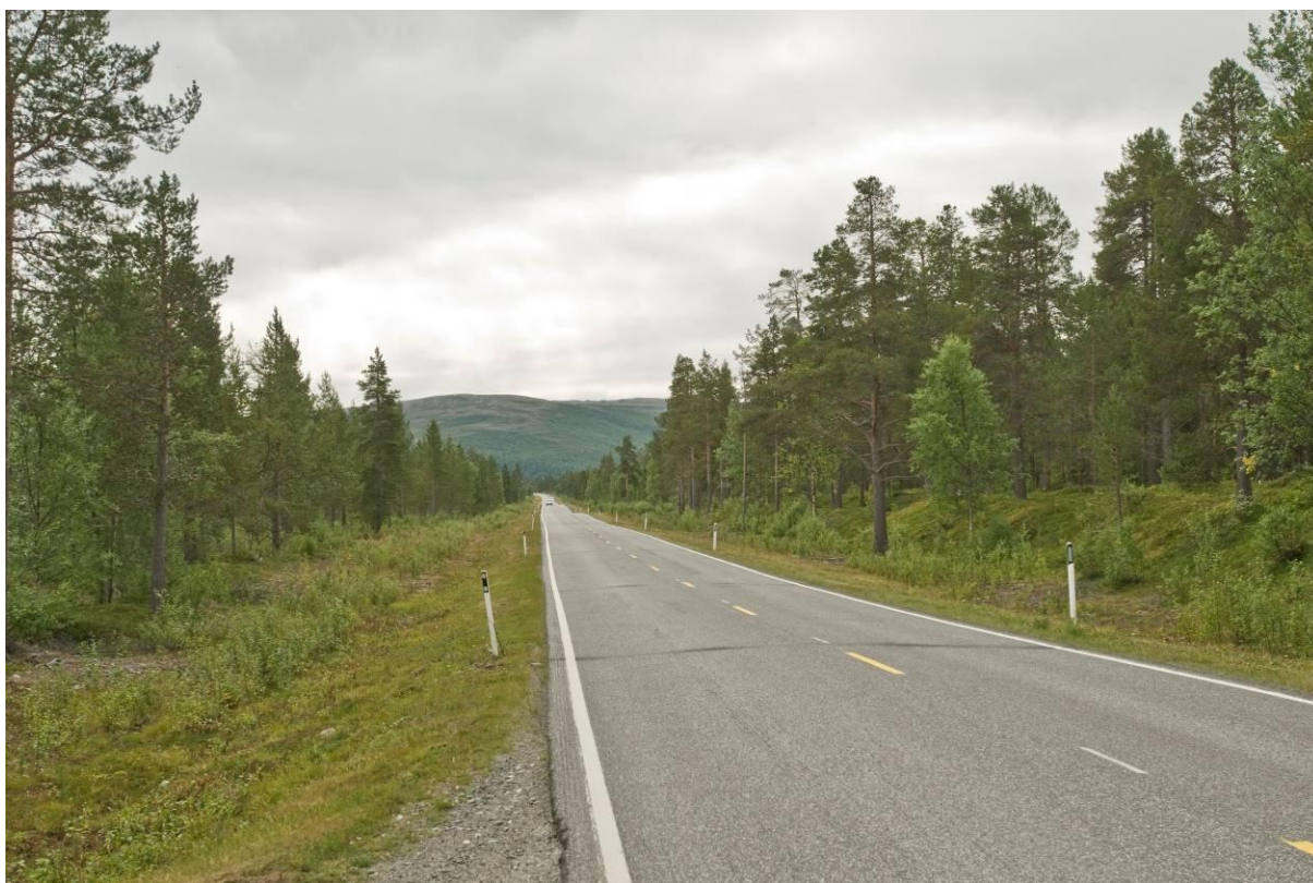
Figur 17: Eibymoen transformatorstasjon vil eventuelt bli liggende i skogen til høyre for riksveien omtrent midt på denne sletta. 420 kV-ledningen mot Skaidi vil krysse rett over veien i samme område. Foto: Einar Berg
