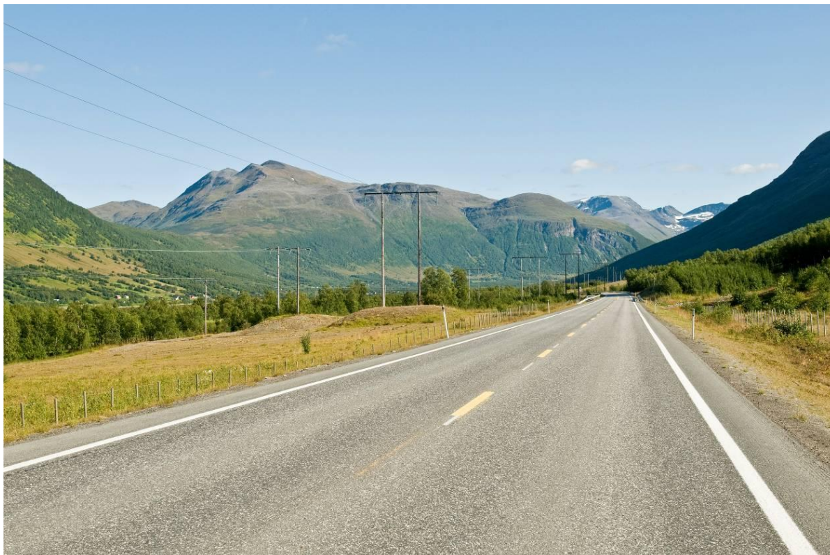
Figur 2: På deler av strekningen inn mot Nordkjosbotn kan det bli opptil fire parallelle ledninger. Foto: Einar Berg.
