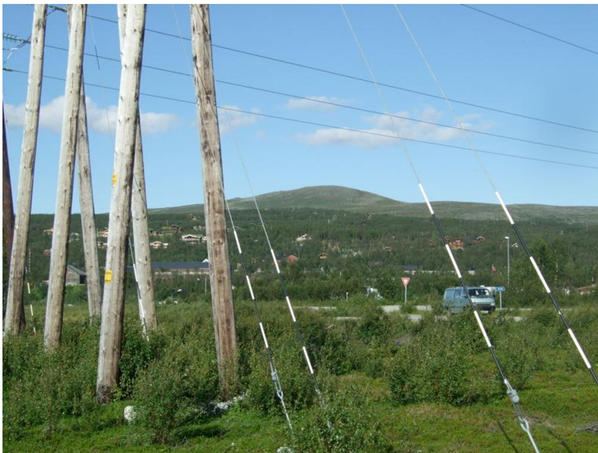
Figur 55: Hytteområdet på Skaidi, Kvalsund kommune, er allerede sterkt berørt av høyspentledninger (foto: Morten W. Melby).
