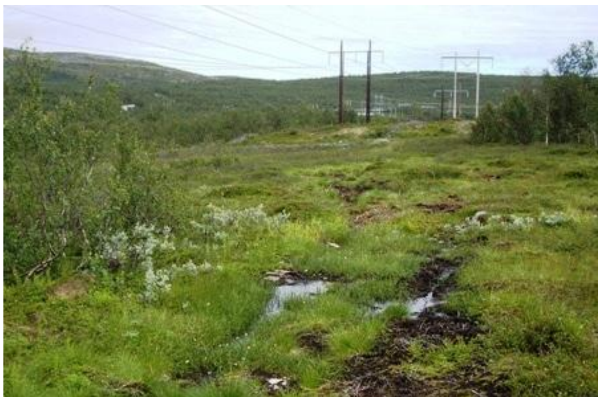
Figur 81: Bildet viser de eksisterende ledninger som vil legges i kabel. Bildet er tatt på østsiden av E6 og man kan se dagens stasjon i bakgrunnen. Viktig at terrenget ikke forandrer seg slik at drivlei fortsatt kan benyttes.
