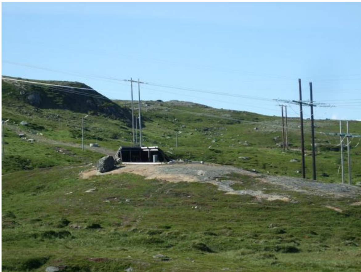
Figur 56: Det er bygd gapahuk under høyspentledninger innenfor det statlig sikrete friluftsområde nær Hammerfest sentrum (foto: Morten W. Melby).
