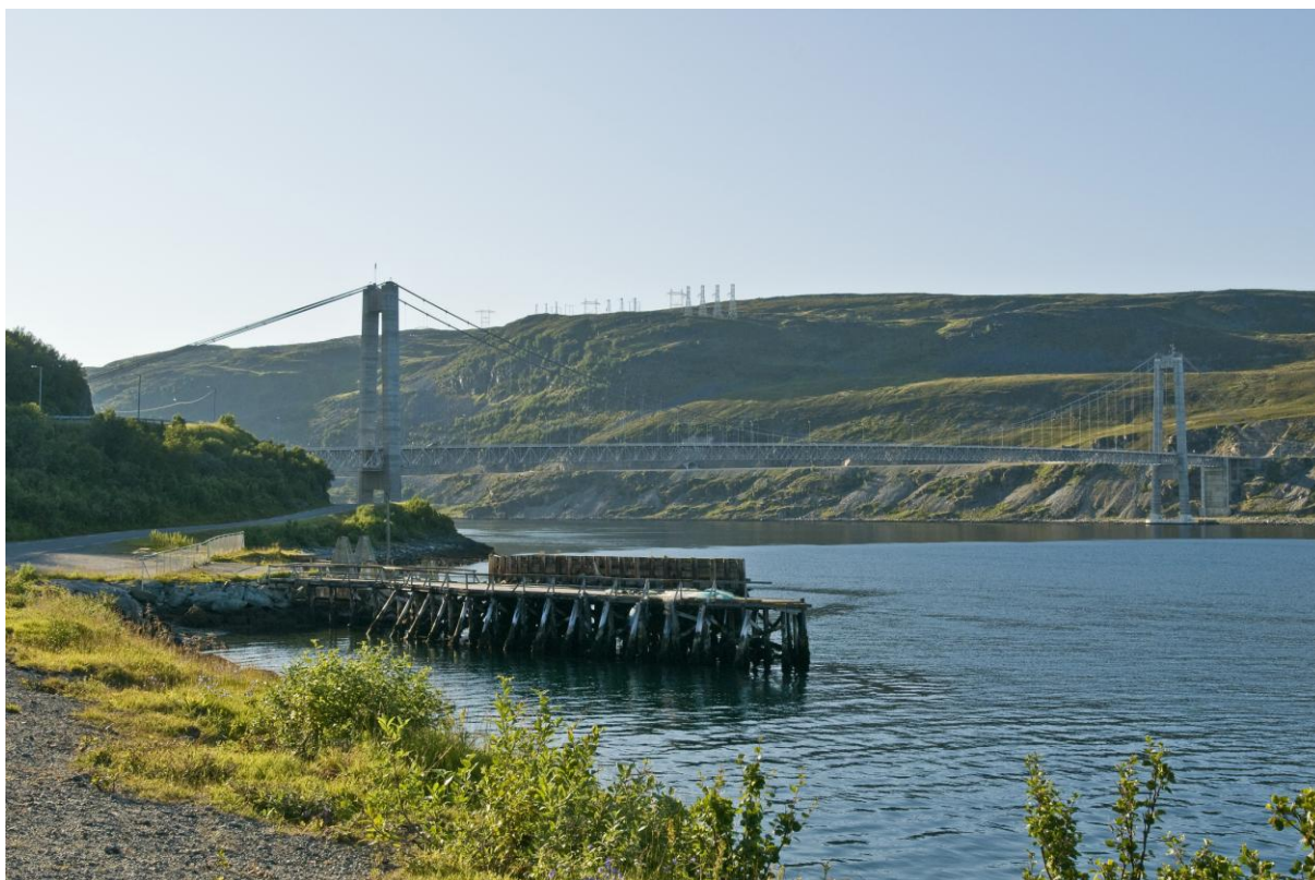
Figur 25: Fotomontasje: Ved kryssingen av Kvalsundet må 420 kV-ledningen føres ut på avspenningsbukker, som kommer i tillegg til de to settene med slike master som er der fra før. Det bør være mulig å unngå flere markører på linene enn det som er situasjonen i dag. Foto og visualisering: Einar Berg
