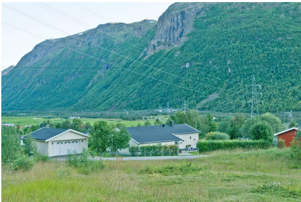
Figur 9: En eventuell ny 132 kV-forbindelse mellom eksisterende og ny transformatorstasjon vil gå i fjellfoten i bakgrunnen av dette bildet. Eksisterende 132 kV-ledning på stålmaster er et ganske dominerende innslag i denne delen av Kåfjordbotn. Foto: Einar Berg
