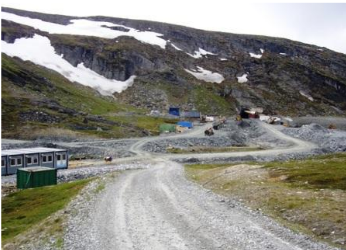
Figur 75: Dagens anleggsarbeid i forbindelse med kraftutbyggingen ved Lassajavri. I nærheten av alt 1.6
