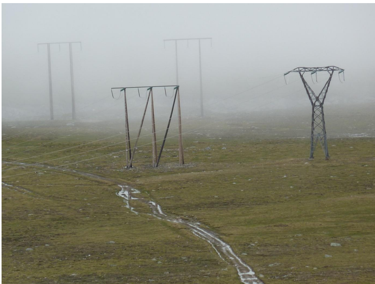
Område langs eksisterende linjer nord for Vuoddojohka. Den nye traseen skal her ligge sør for de eksisterende, dvs. til høyre i bildet. Foto: A. Hesjedal
