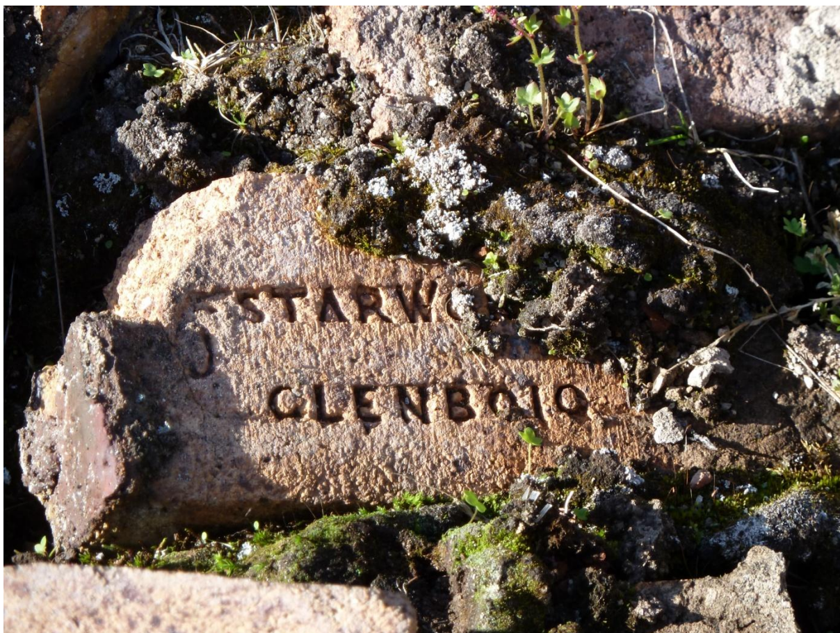
Teglstein fra Star Works i Glenboig i Skottland ble ansett for å være Storbritannias beste tegl og ble brukt for å bygge anlegget i Kåfjord. Foto: A. Hesjedal
