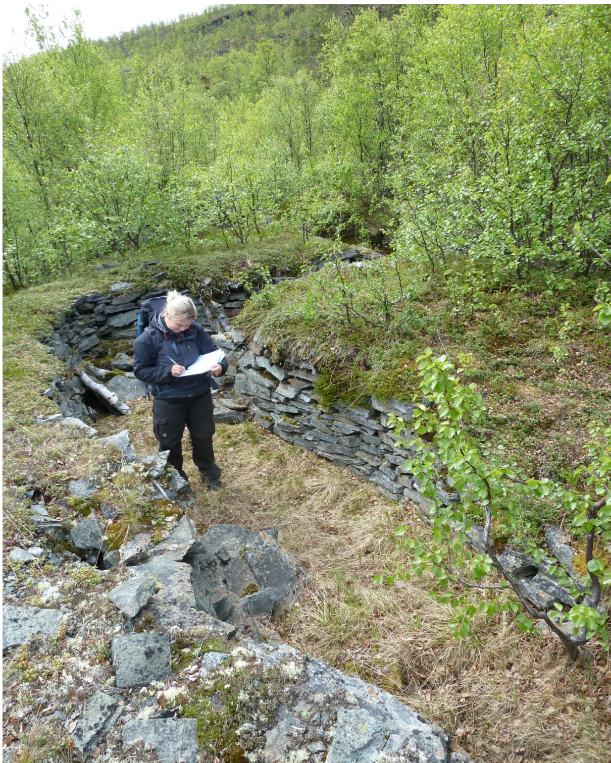
Tysk skyttergrav i Skibotndalen, Storjord kommune. På grunn av sementmangel (all sement ble i 1944 sendt til forsvarsverker på kontinentet) ble betongmurer erstattet av tørrmurer som vist på bildet Foto: S.Sandess.
