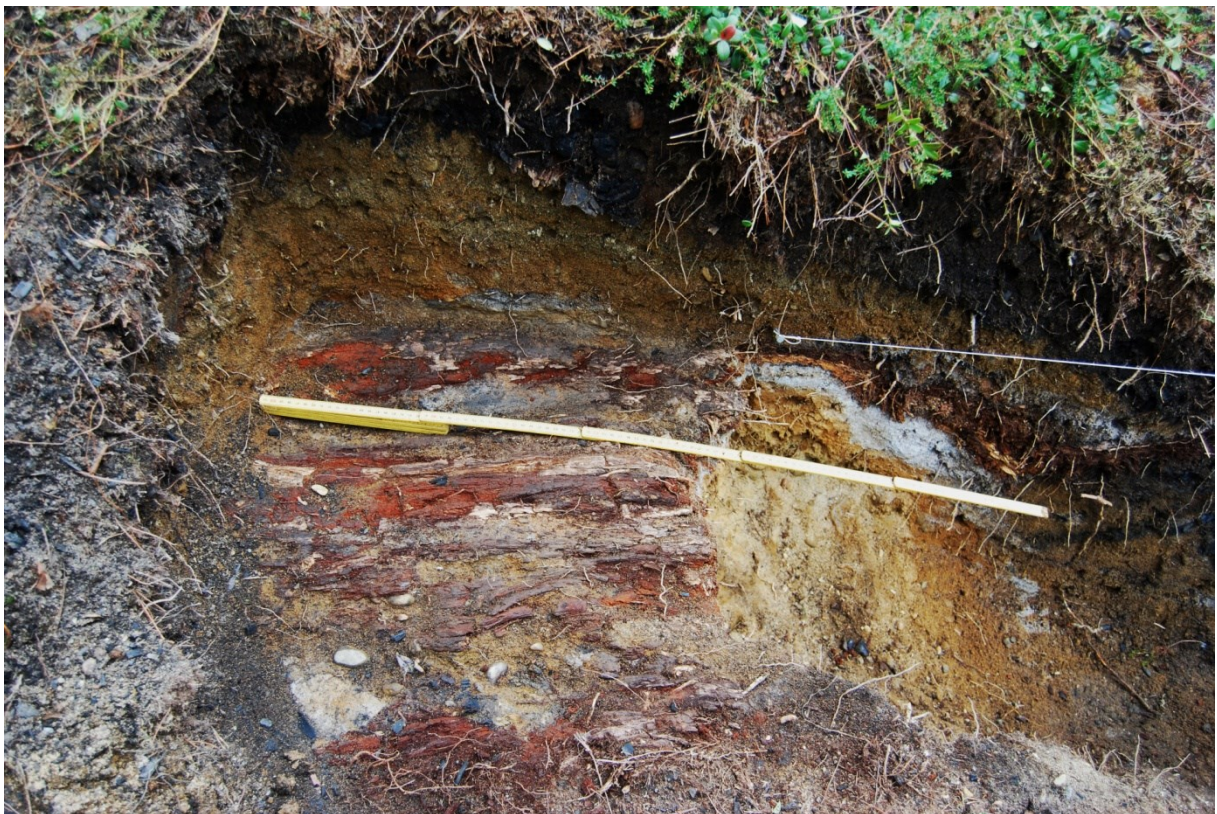
Figur 7: Foto av bjelkelaget øst for tapperenne. Foto tatt mot nord.
