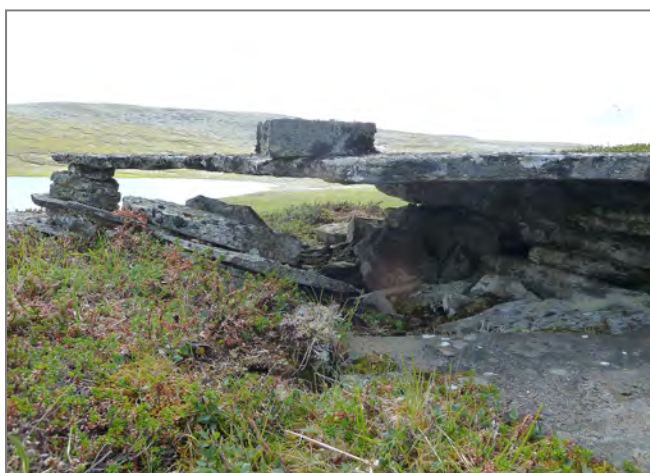
Figur 64: Steinkonstruksjon ved Vuodđojávrrit (ID 149890). (Foto: A.Klokkervoll)
