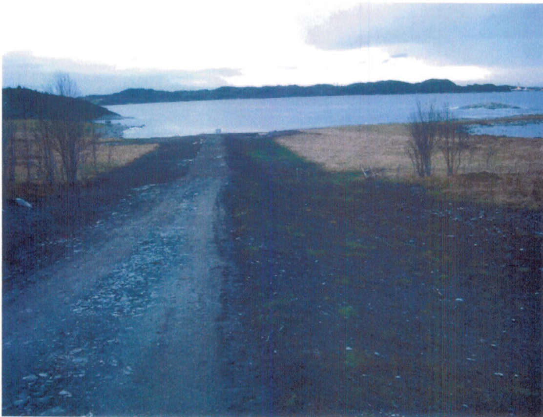
Bilde 4: Jordkabelanlegg etter at kabelgrøft er gjenfylt og terreng reetablert
