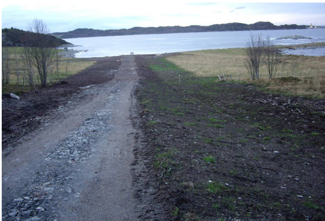
Figur 14 Jordkabelanlegg etter at kabelgrøft er gjenfylt og terreng reetablert
