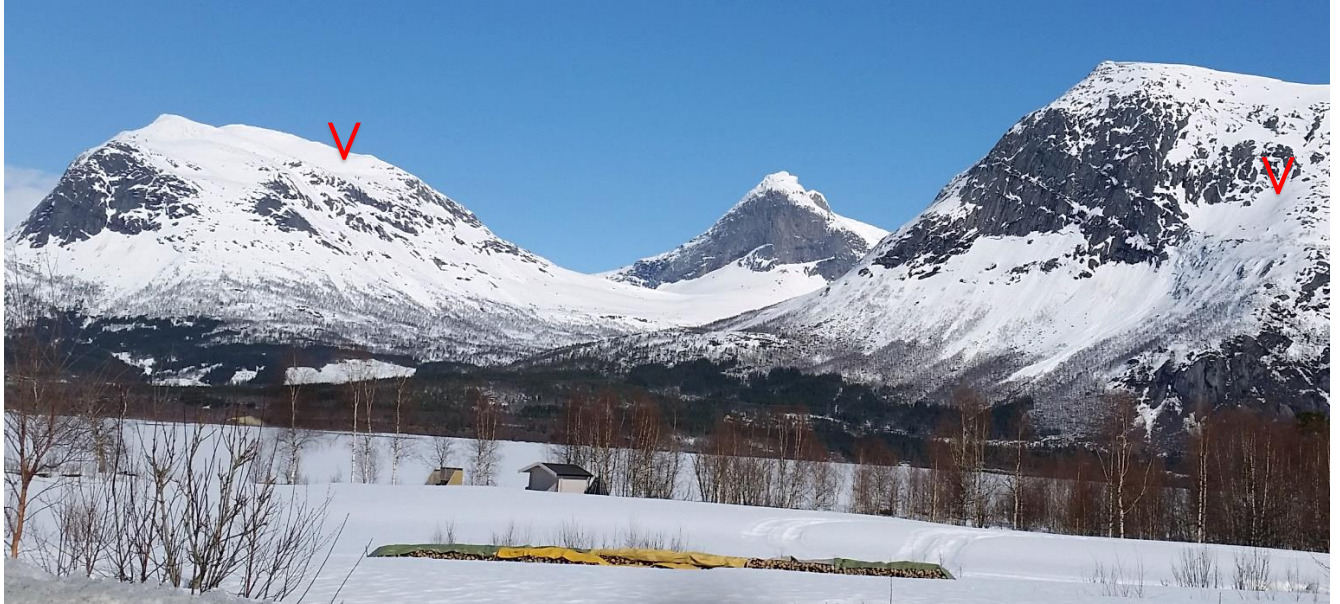
Bildet viser tiltaksområdet, med Kobbelv kraftverk til høyre i bildet og den nye stasjonen til venstre. Foto: NVE
