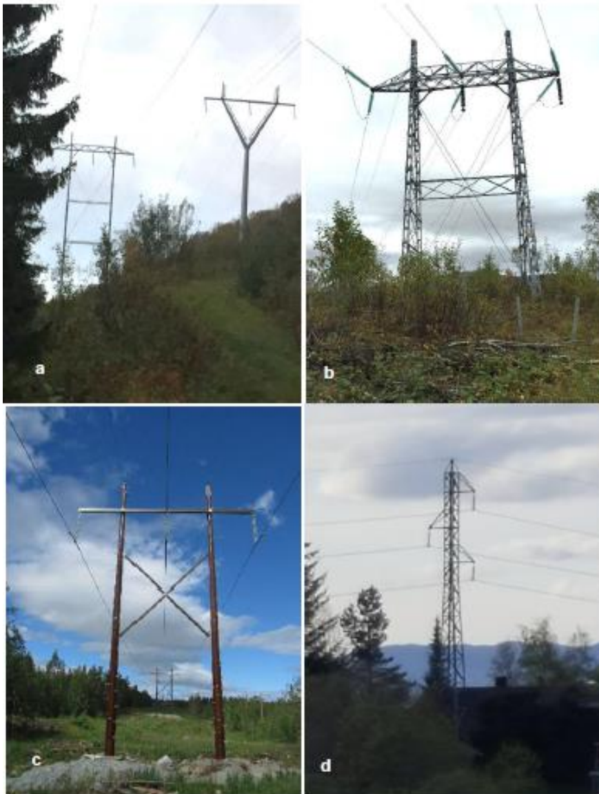
Figur 3-6 a) Rasmast ved Bogen til høyre, selvbærende standard portalmast venstre. Begge er 132 kV. b) En typisk forankringsmast, 132 kV. c) 132 kV komposittmast med ståltravers. d) Enkeltfaset mast med trekantoppheng (denne er 66 kV). Foto: Statnett.
