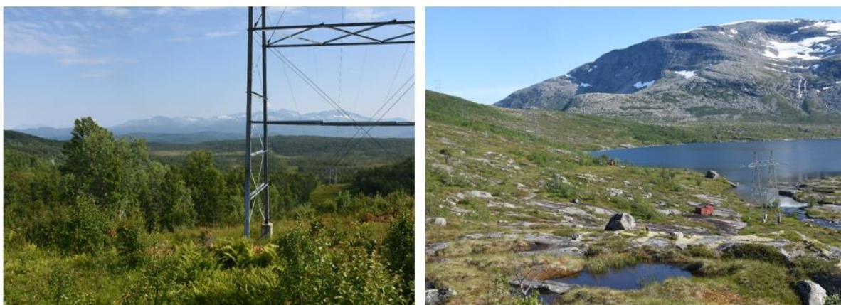
Figur 8-14 Til venstre: Alt. 1.0 like vest for Lysvatnet, nord for Kvantotoppen. Bildet er tatt mot øst og Evenes. Til høyre: Østover langs dagens trase ved Trollvatnet der foreslått trase 1.5 går sør for (til høyre for dagens trase). Foto: Sweco Norge.
