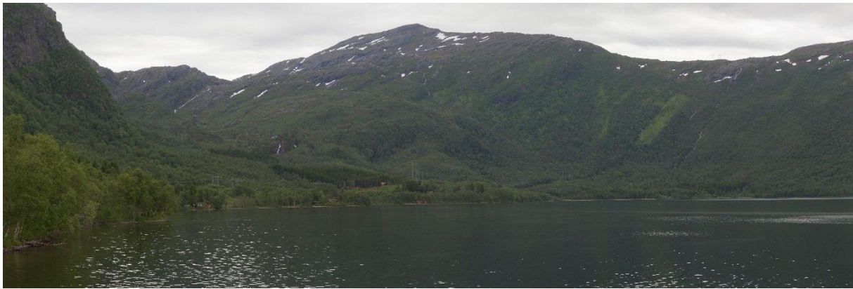
Figur 4-6 Ved Niingen kraftverk ved Strandvatnet ser man hvordan de parallellførte kraftledningene både bryter horisontlinjen ved Sauen og danner et iøynefallende ryddebelte. Foto: Sweco Norge AS v/Marius Fiskevold
