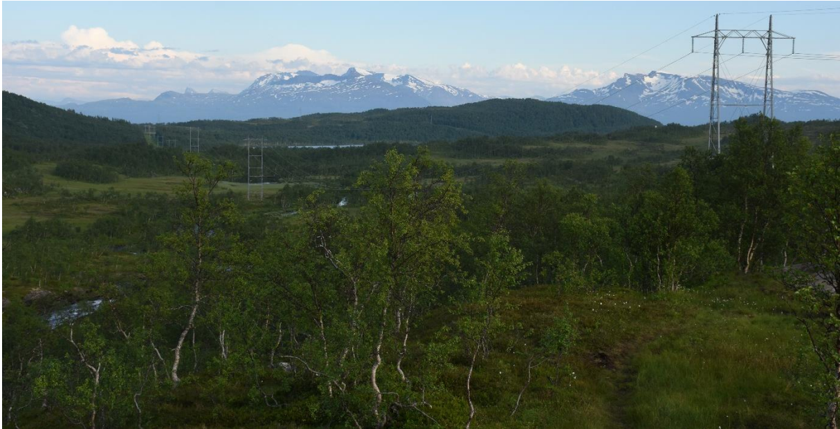
Figur 8-21. Alt. 1.2 følger dagens Kvitnesledning mellom Laksåvatnet i bakgrunnen og Klubbfjellvatnet. Foto: Sweco Norge.
