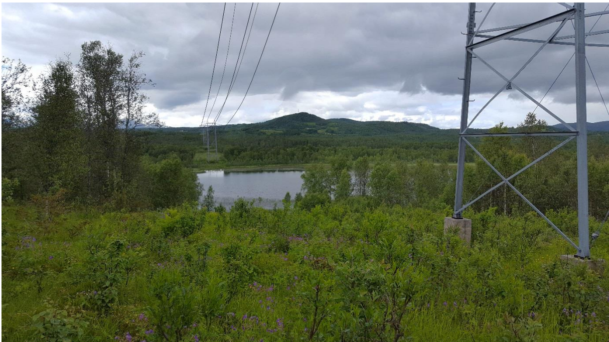
Figur 4-27 Fotomontasje som viser alternativet med høy mast ved Sommarvatnet nordvestover mot Boltås. Foto: Statnett v/Gunn Frilund.
