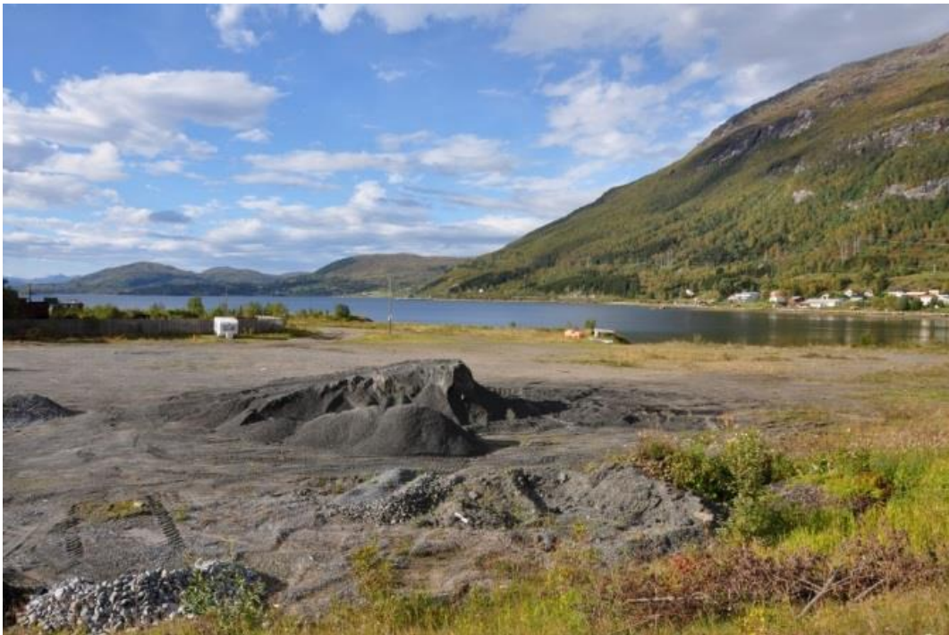
Figur 4-5 Utsyn fra Bogen sørvestover mot Dragvik. Eksisterende og planlagt kraftledning ligger i lia til høyre. Foto: Sweco Norge AS v/Nina Marie Andersen
