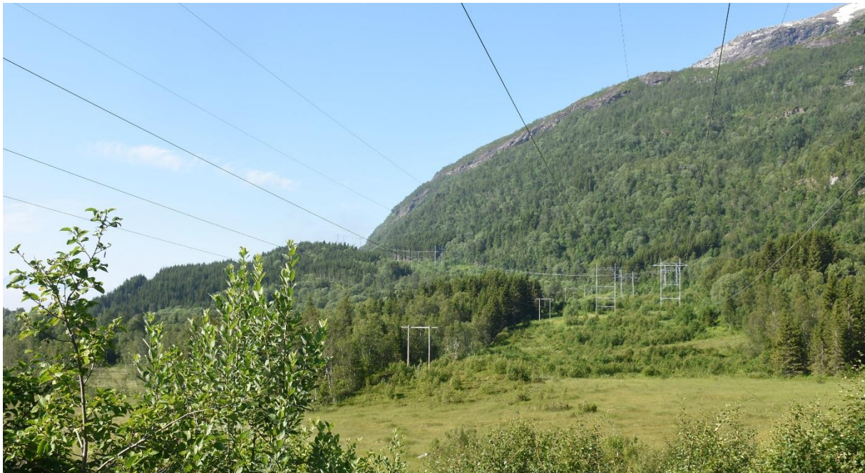
Figur 8-32. Brattåsmyra i Bogen krysses av tre parallelle ledninger. Foto: Sweco Norge
