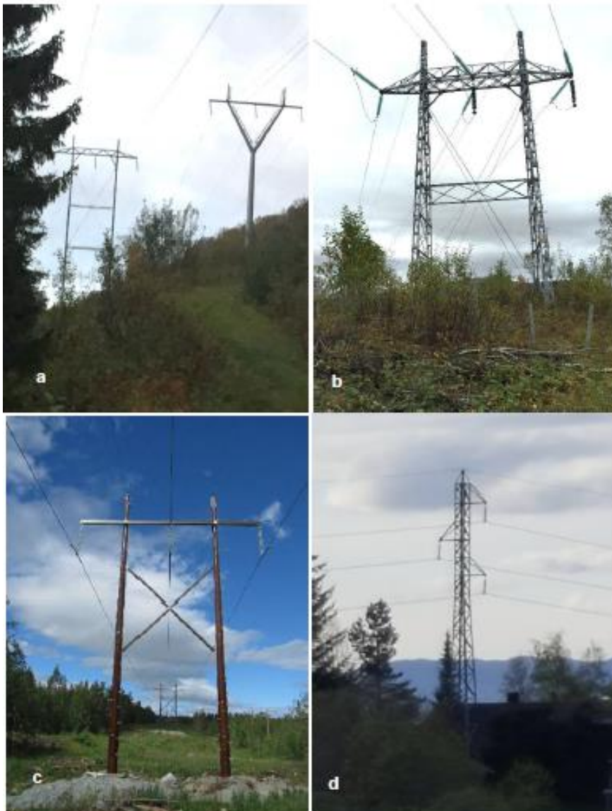
Figur 3-6 a) Rasmast ved Bogen til høyre, selvbærende standard portalmast venstre. Begge er 132 kV. b) En typisk forankringsmast, 132 kV. c) 132 kV komposittmast med ståltravers. d) Enkeltfaset mast med trekantoppheng (denne er 66 kV). Foto: Statnett.
