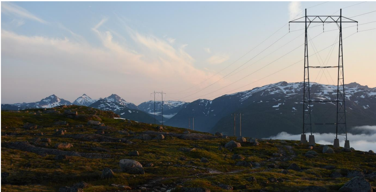
Figur 7-9. Dagens ledning øst for Kanstadbotn. Foto: Sweco Norge.
