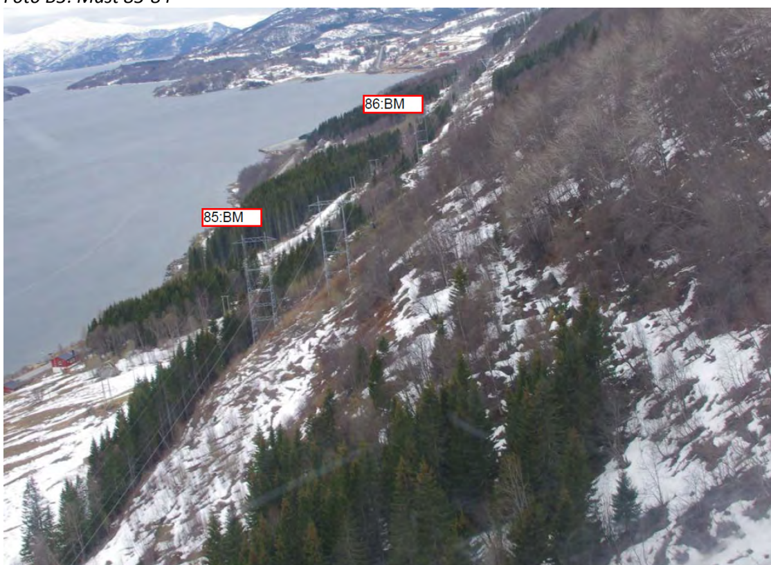
Foto B4: Mast 85-86
