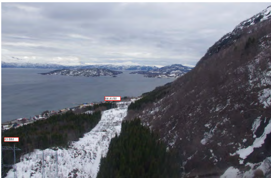
Foto B3: Mast 83-84
