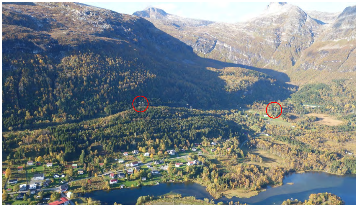
Foto B8: Rød ring viser mast 83 (venstre) og mast 80 (høyre).
