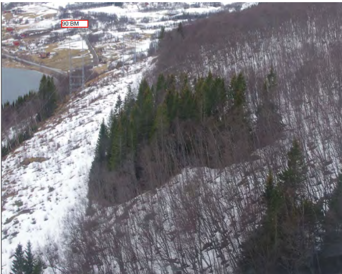
Foto B6: mast 90
