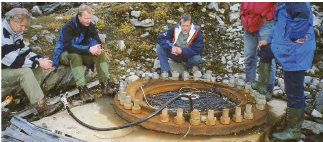
Figur 7-1 Skredmast tatt av snøskred på NGIs forskningsfelt i Ryggfonn på Strynefjellet i år 2000.
