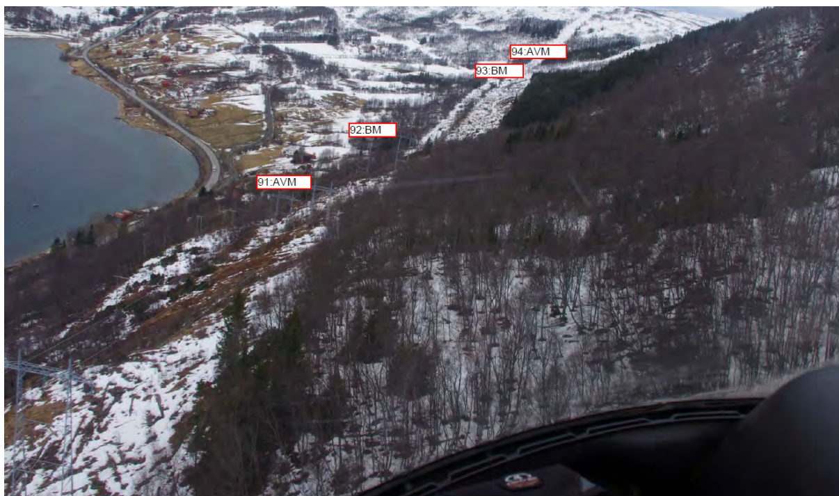
Foto B7: Mast 91-94
