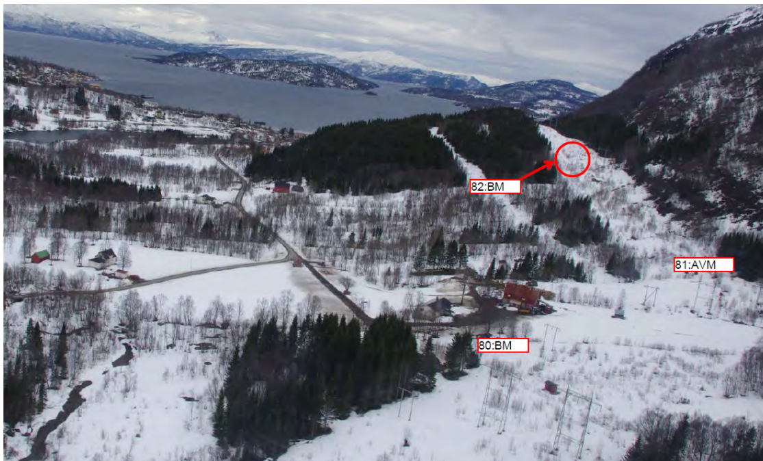
Foto B1: Mast 80-82
