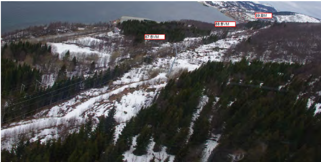
Foto B5: Mast 87-89
