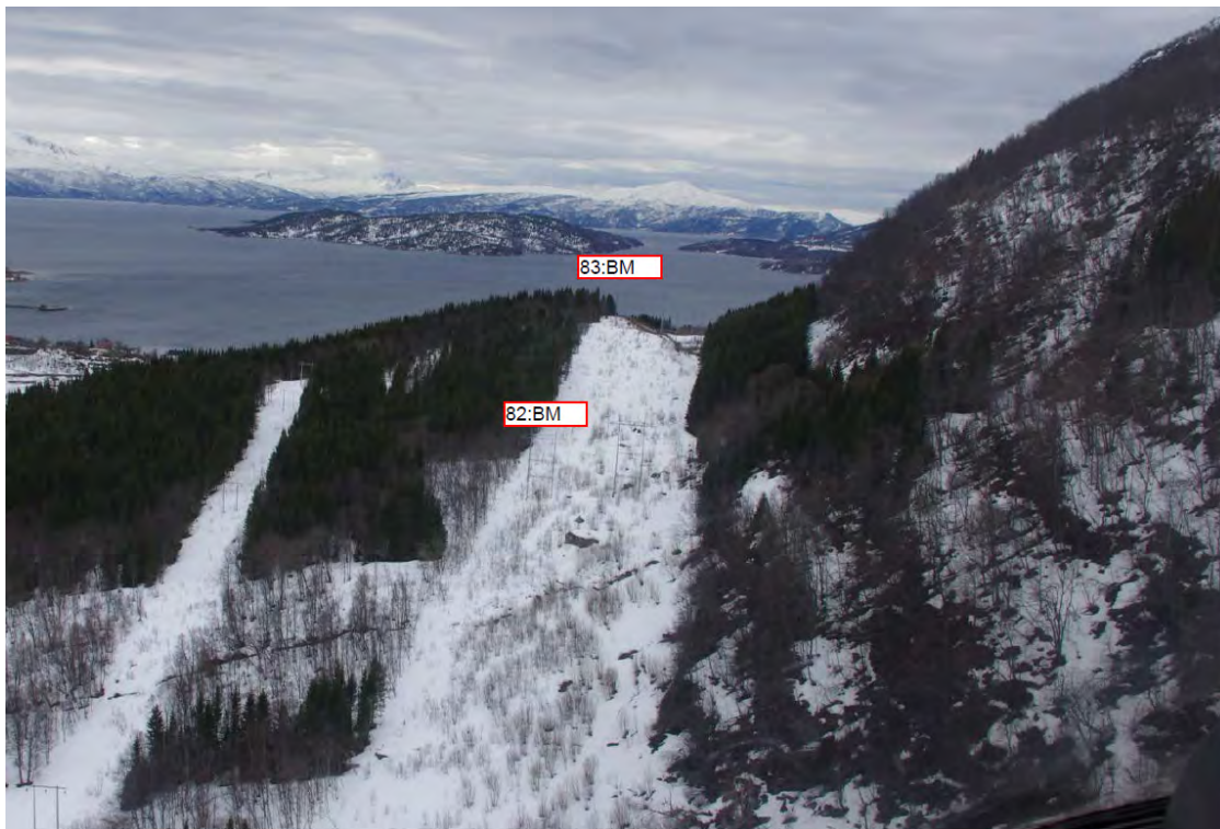
Foto B2: Mast 82-83
