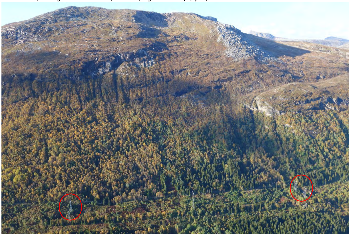
Foto B10: Rød ring viser mast 88 (venstre) og mast 86 (høyre). Skredmasten i midten.
