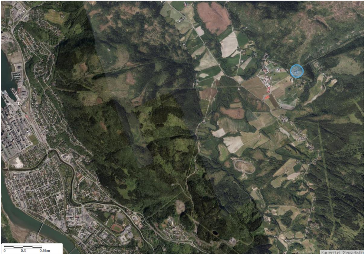
Figur 7 Landskapet fra Mosjøen i vest til Marka i øst. Sirkelen viser transformatorstasjonen.
