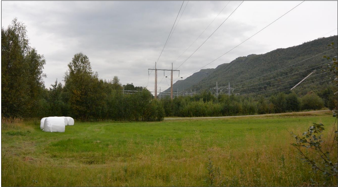
Figur 1-3. Deler av jordbruksarealet i ryddebeltet rett vest for eksisterende transformatorstasjon.
