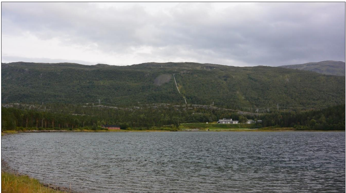
Figur 1-7. Rørgata og massetipp er tydelige blikkfang i området. Dagens transformatorstasjon ligger bakenfor Gardelvågbergan, som er bergene som vises sentrert i bildet.
