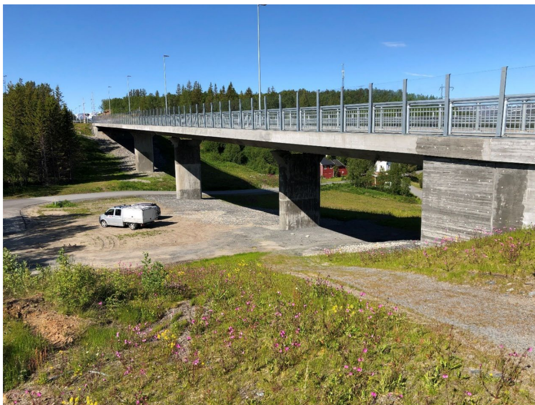
Figur 10: Bilde tatt på Øyjord. Ved utgang Hålogalandsbrua, går kabeltraseen nordover før den krysser under E6 og videre Øyjordvegen, før den går opp til kabelendemast ovenfor og bak det røde huset
