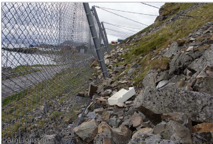
Figur 4. Eksempel på 4 m høyt steinspranggjerd som også viser netting, stolper og barduner.
