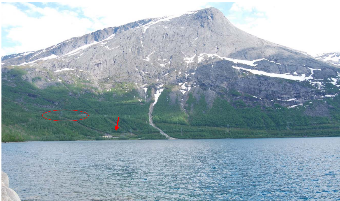
Figur 2 Bildet er tatt fra vegen langs Straumsvatnet i retning øst og viser Durmålstinden med Straumsvatnet og Siso kraftverk i forgrunnen. Nytt stasjonsområde er markert med rød sirkel i bildet og rød pil markerer areal som planlegges benyttet til permanent massedeponi.
